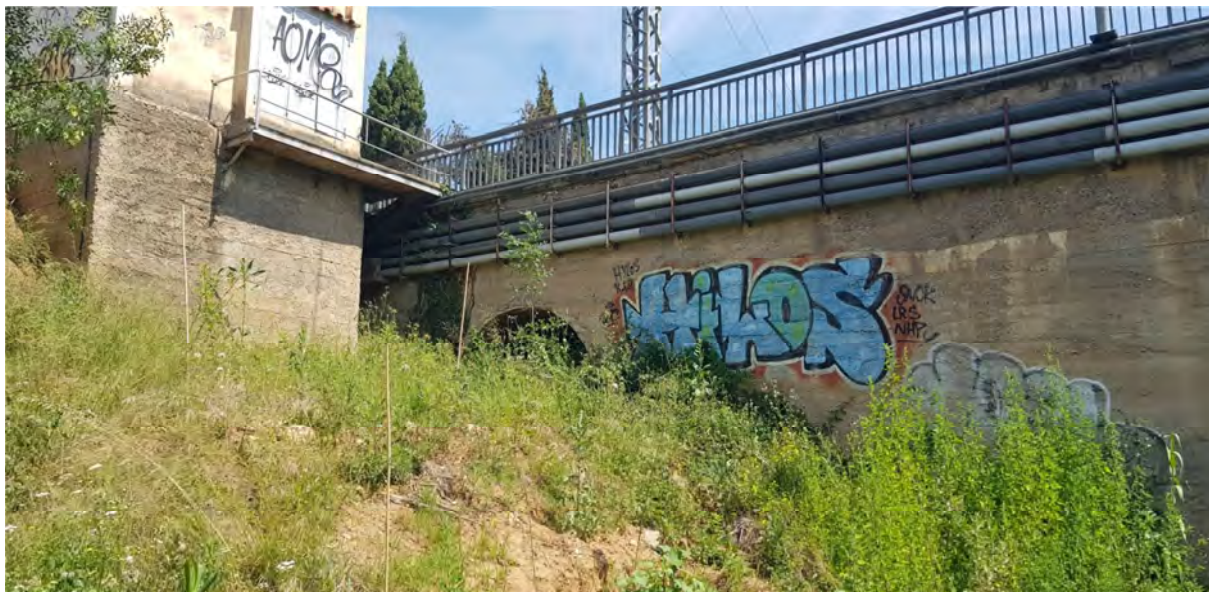
Imatge 20. Ull parcialment tapat del marge dret del pont de Can Noguera
