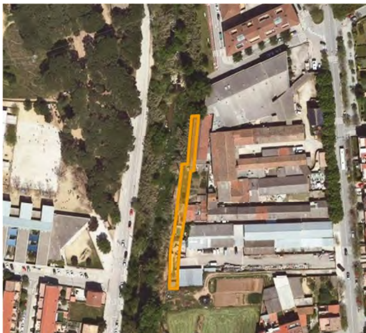
Imatge 65. Zona on la zona de servitud del Domini Públic Hidràulic està ocupada de forma irregular, infringint l'article 7 del Reglament del Domini Públic Hidràulic
