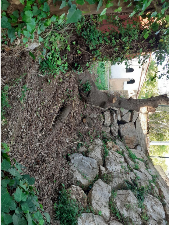
Figura 4: Vista de la ubicació a on es troba una canonada de reg que es desviaria com a part del projecte.
