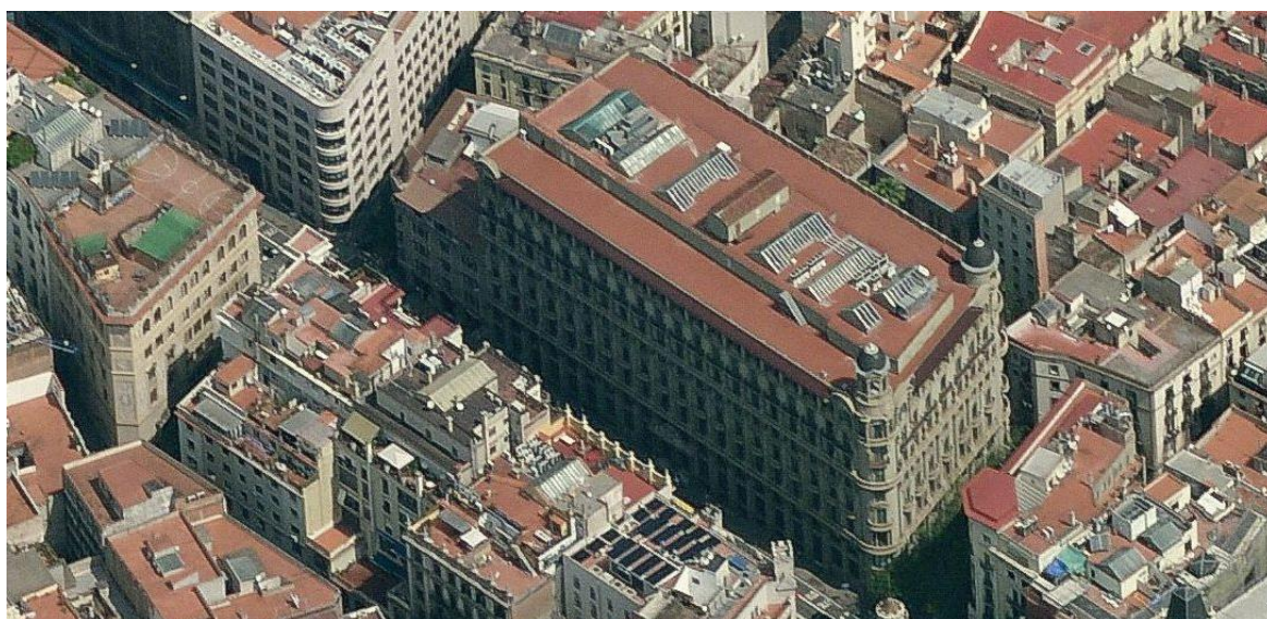
Fotografia aèria de la façana del carrer de Via Laietana
