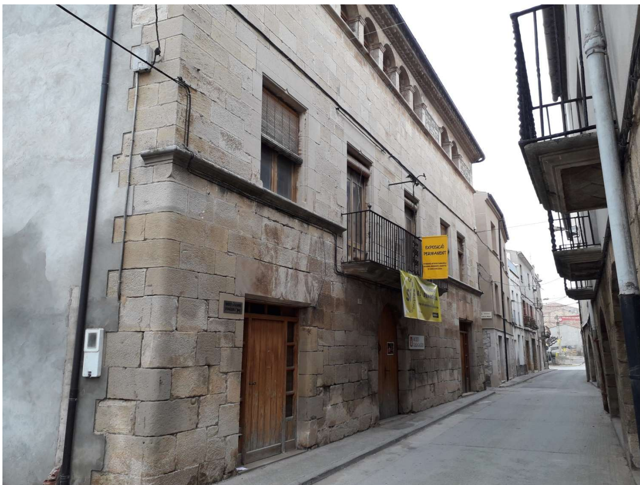
Accés a la Casa de la Cultura "Can Gassol"
