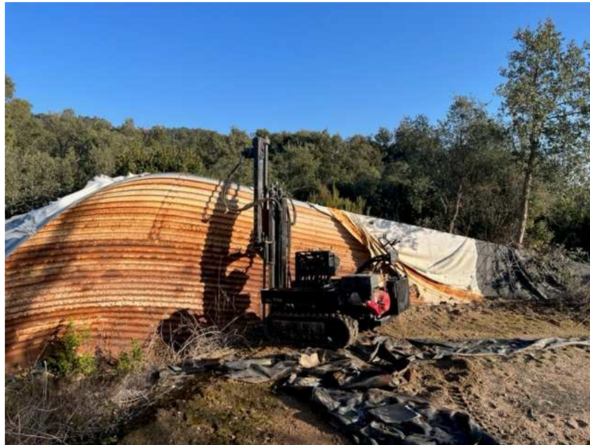
Foto 3. Situació i execució del penetròmetre 3.
