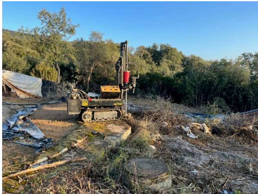
Foto 1. Situació i execució del penetròmetre 1.
