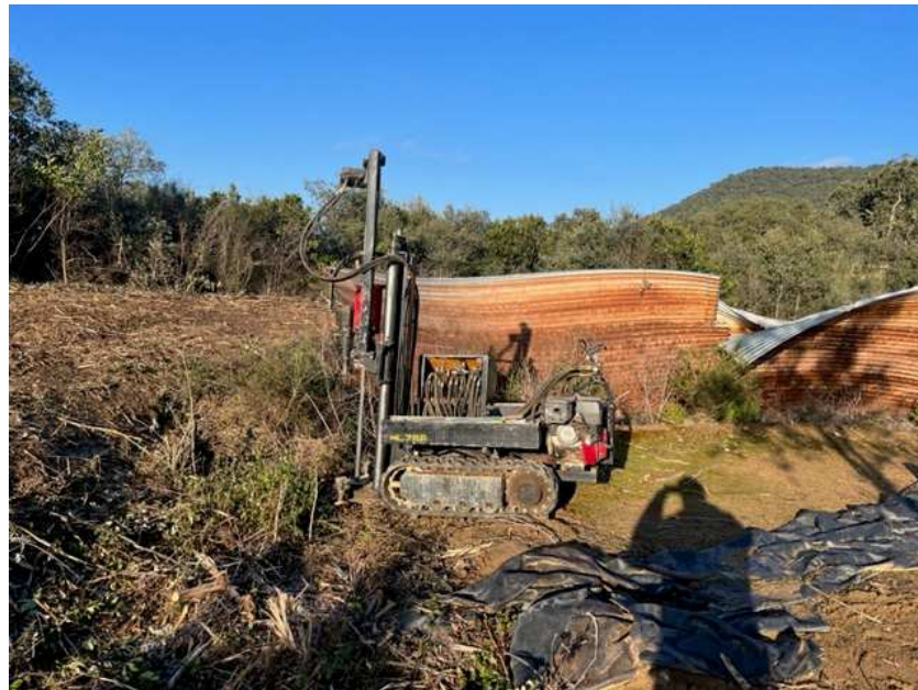
Foto 2. Situació i execució del penetròmetre 2.
