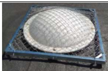
Figura 3. Ejemplo protección claraboyas con enrejado
