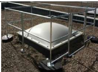
Figura 3. Ejemplo protección claraboyas con barandilla
