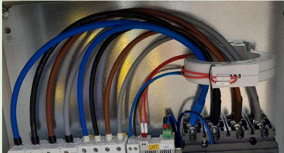
Exemple d'un quadre elèctric amb proteccions AC on s'utilitzen punteres i terminals
