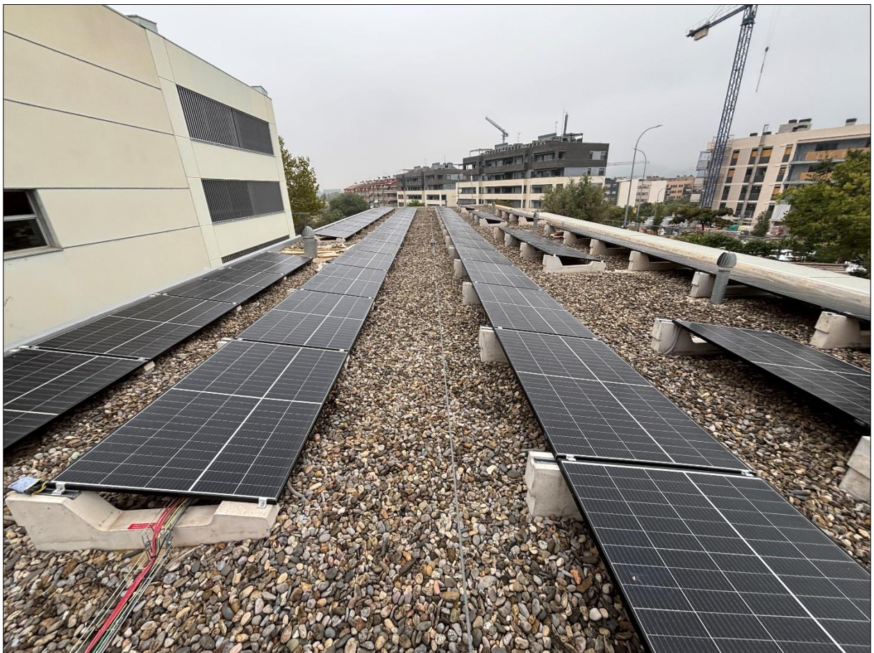
Instal·lació FV existent sobre coberta a desmuntar i instal·lar posteriorment
