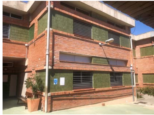
Vista mòdul façana zona actuació. Tram exterior
