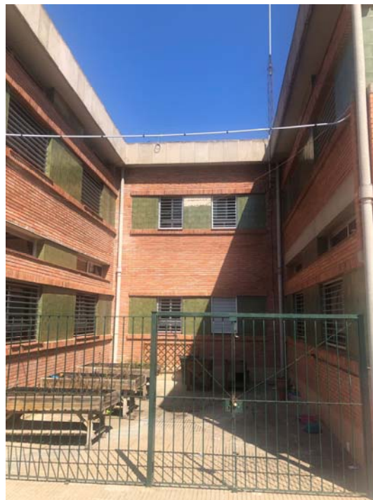
Vista mòdul façana zona actuació. Tram interior tester
