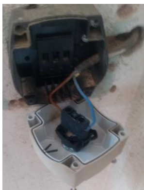
Pulsador d'aturada d'emergència amb una única cambra.
