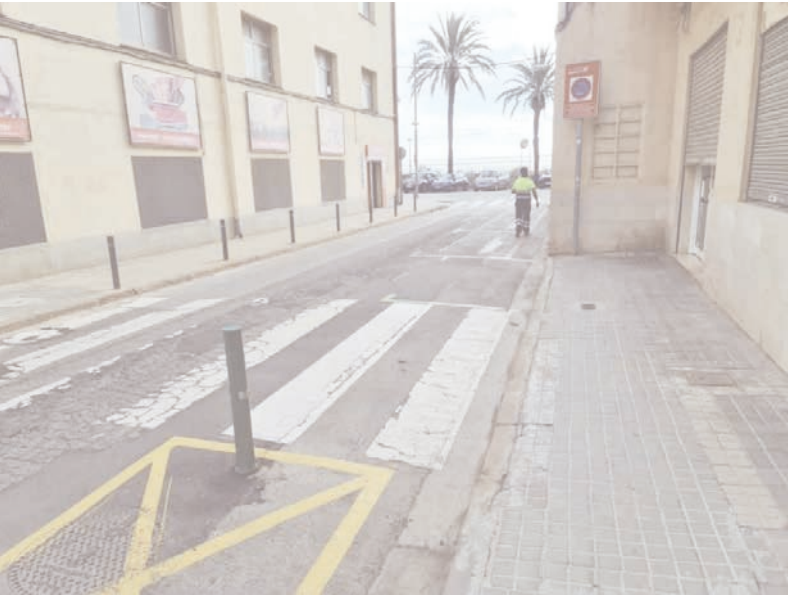
Arquitecte: Mireia Serra Sala
