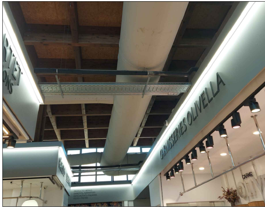
Vista inferior col·lector general
