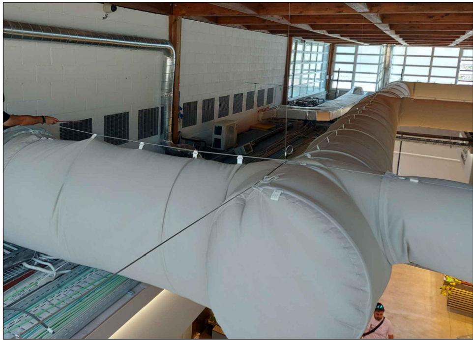
Col·lector general a mantenir i col·locar peça especial per baixar els 3 ramals
