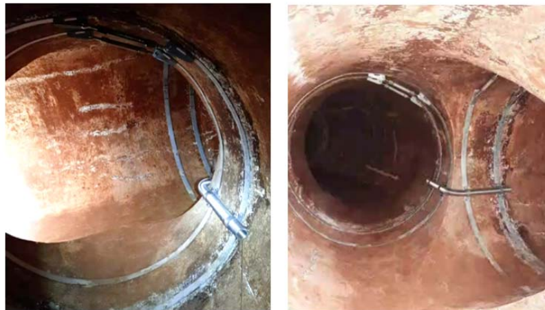
Il·lustració 3. Tub de protecció en els colzes
