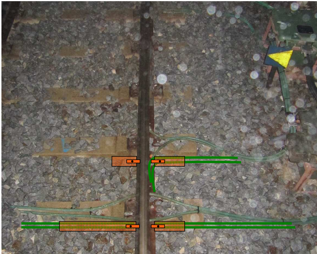
Figura 3.4 Model correcte d'implementació del cablejat
