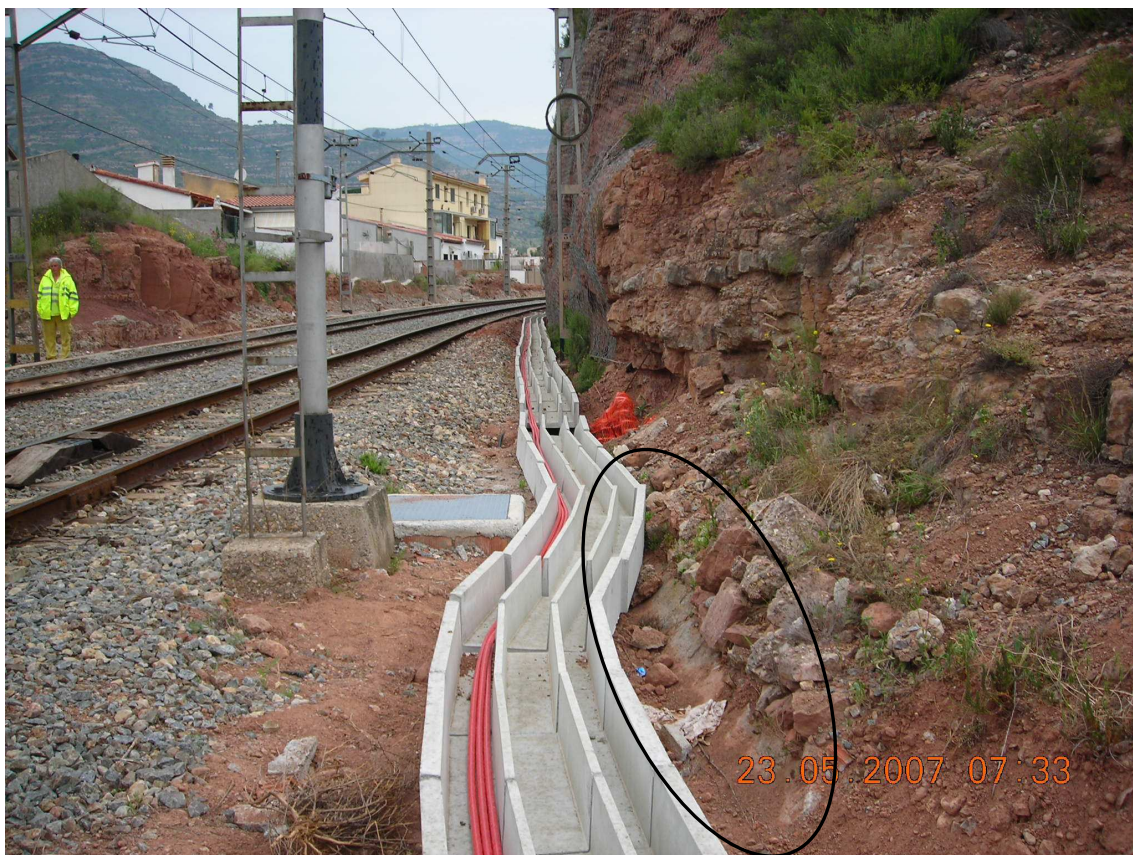
Figura 3.6 Exemple de cuneta tapada per la canalització de cablejat.
