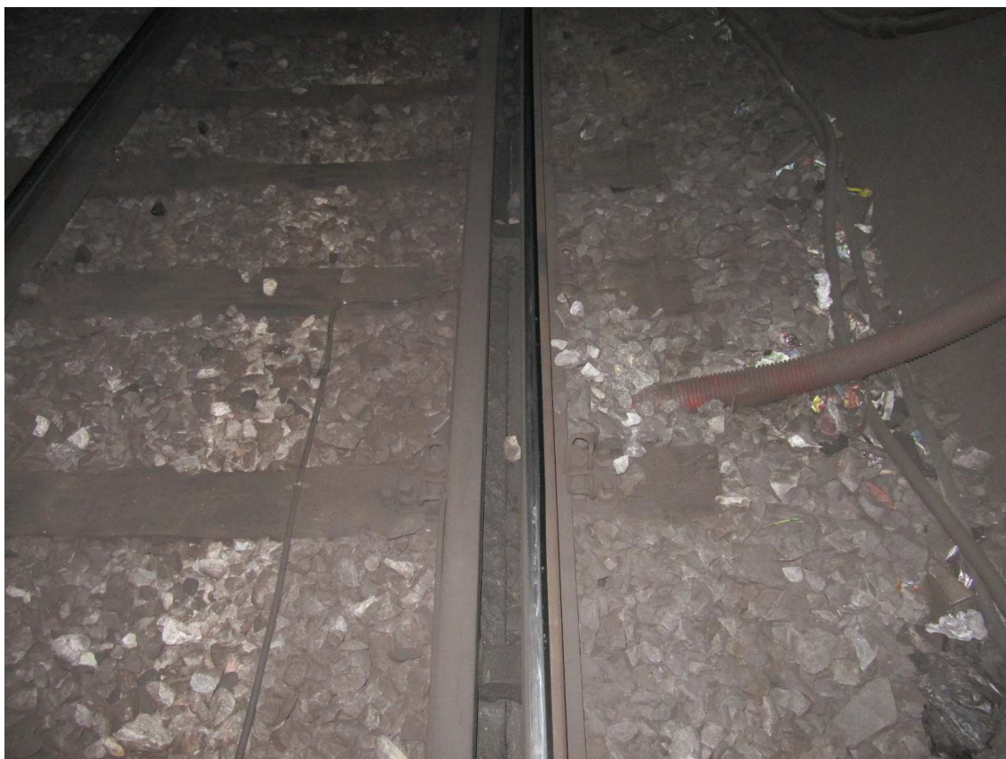
Figura 3.3 Exemple de cablejat no respectant la distància de 60cm sota travessa
