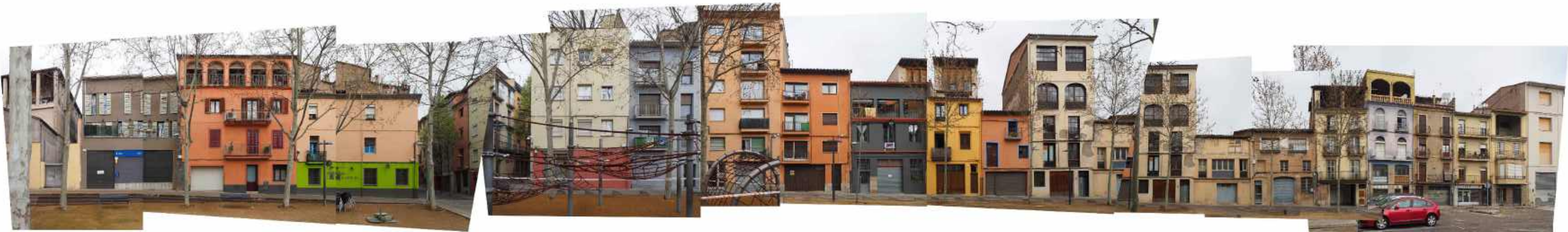
Vista edificis front nord-est
