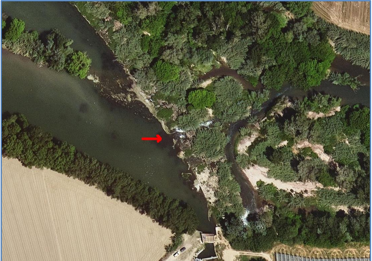
Obertura en la coronació de la Resclosa de Canet
