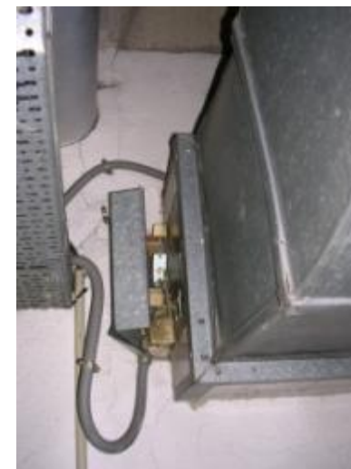
042 Comportes tallafocs conductes
