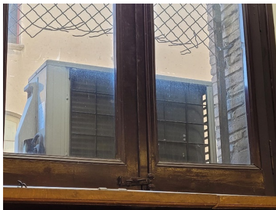
079 Condensadora corresponent amb foto 078
