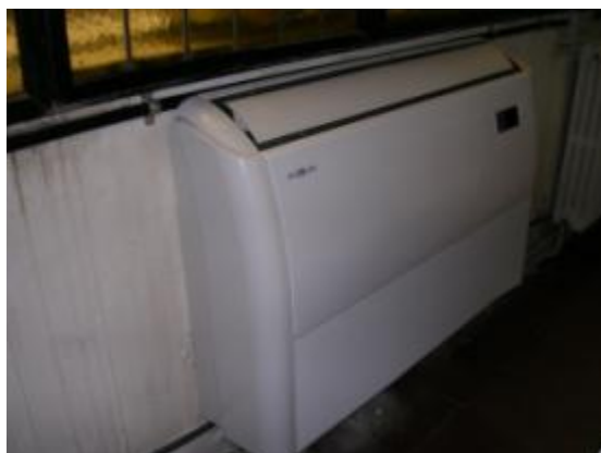
072 Magatzem gravats dreta
