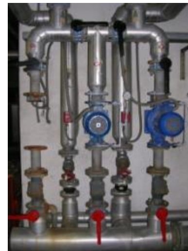
030 Bombes recirculació B2.1, B2.2 i B2.3
