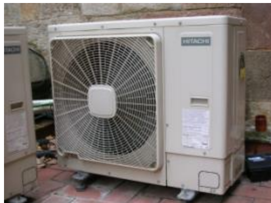
130 Condensadora corresponent amb foto 121
