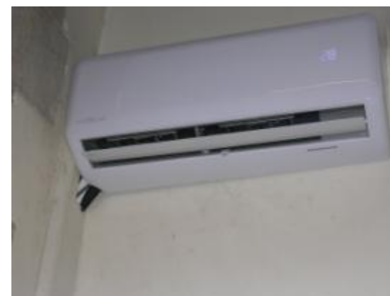
074 Despatx magatzem gravats
