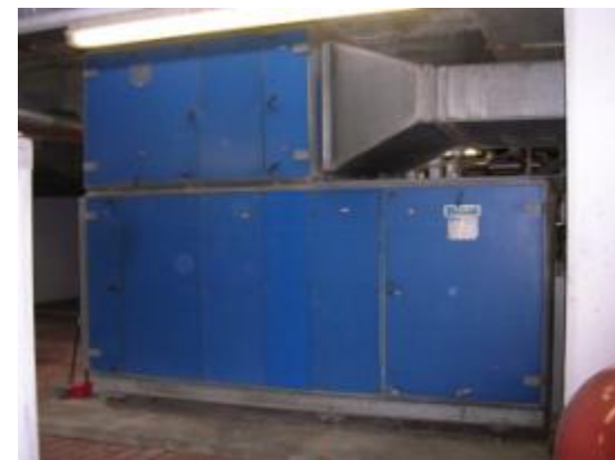
027 Climatitzador amb recuperador entàlpic CL2
