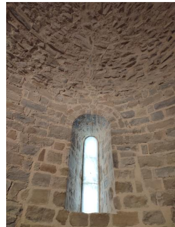
Il·lustració 6: Vista parcial de la zona interior de l'absis. Hi podem observar que la finestra fou totalment refeta en una data indeterminada a l'igual que la volta que al·lucina.
