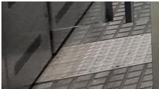
1 Safata pas cablejat
