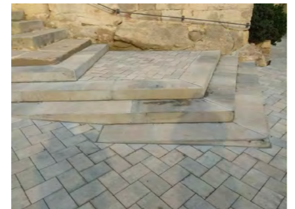
Exemple paviment exterior de llambordes de formigó, color sitges i es glaons prefabricats de formigó.
