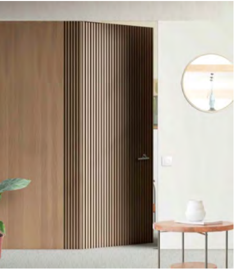
Exemple aplacat de porta i paret amb panell fonoabsorbent de llistons de fusta.
