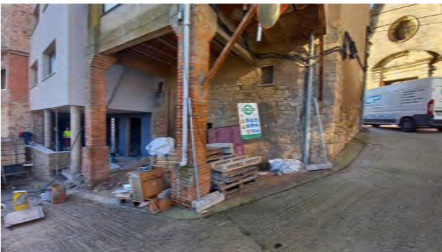
Estat actual del porxo d'accés
