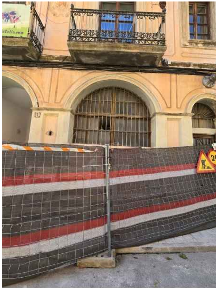
1. FUSTERIES EXTERIORS DE FUSTA, NO ESTANQUES, VIDRES TRENCATS I MAL CONSERVADES. CAL SUBSTITUCIÓ SEGUINT MATEIXOS CRITERIS ESTÈTICS.
