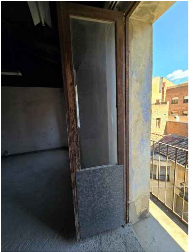
1. FUSTERIES EXTERIORS DE FUSTA, NO ESTANQUES, VIDRES TRENCATS I MAL CONSERVADES. CAL SUBSTITUCIÓ SEGUINT MATEIXOS CRITERIS ESTÈTICS.
