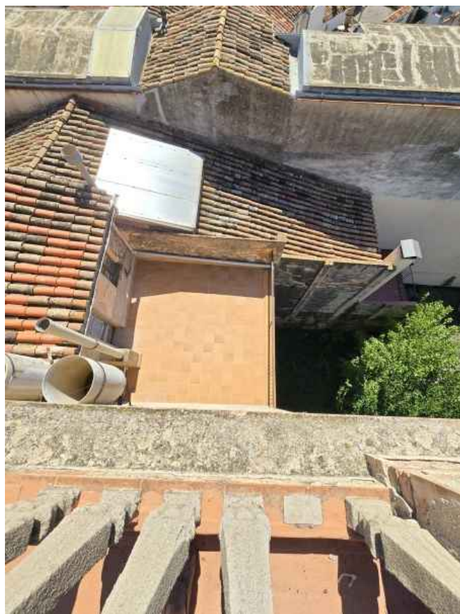
4. TORREÓ CAP A LA TERRASSA 1 POSTERIOR. ARRANJAMENT DE BALUSTRADA
