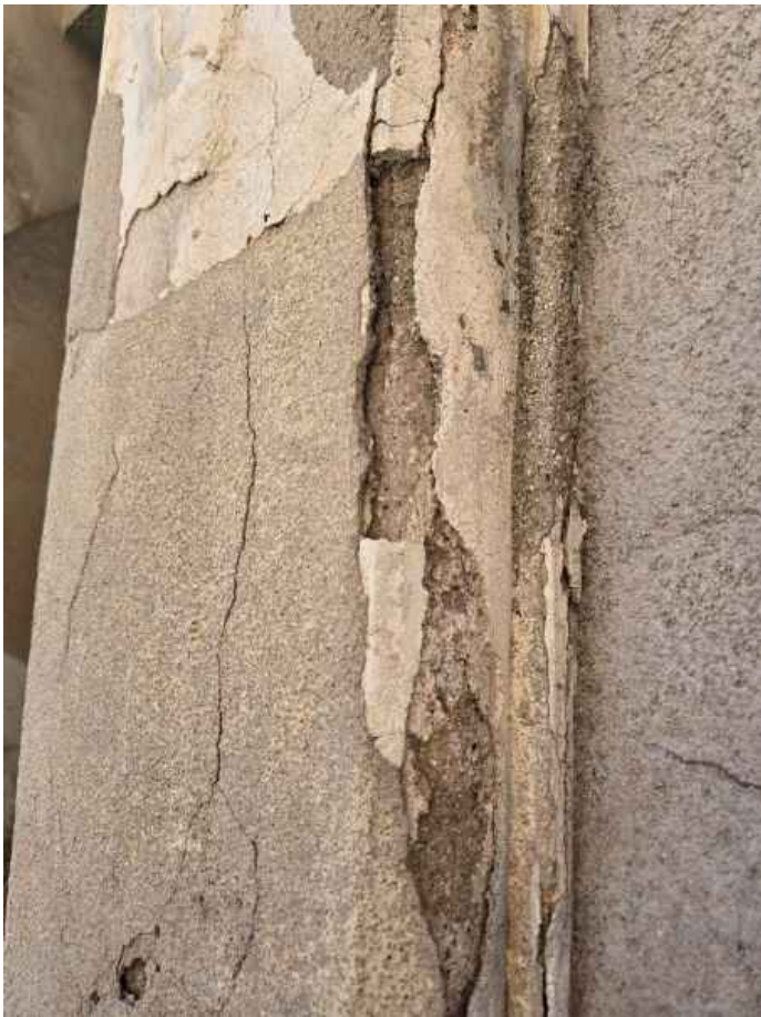
1. 2. 3. ABOMBAMENT, TRENCAMENT I DESPRENIMENT DE LA CAPA DE MORTER DE CALÇ ORIGINÀRIA. ES POT OBSERVAR QUE HA ESTAT REPARADA PER TAL D'EVITAR CAIGUDA D'OBJECTES A LA VIA.
