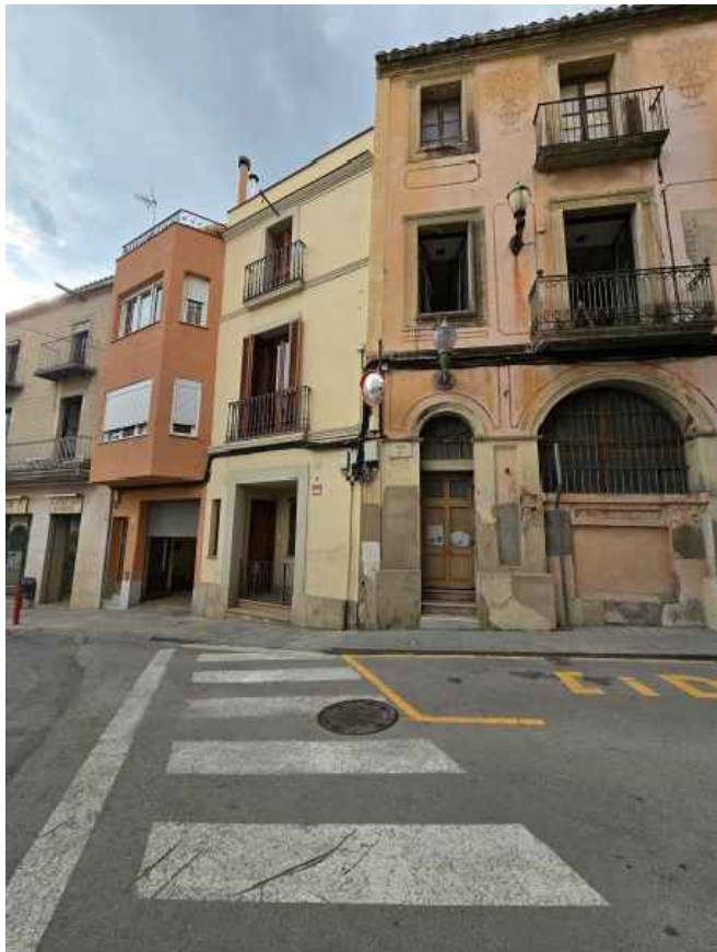
4. FAÇANA CARRER VIC, FINCA VEÏNA PEL SUD-EST
