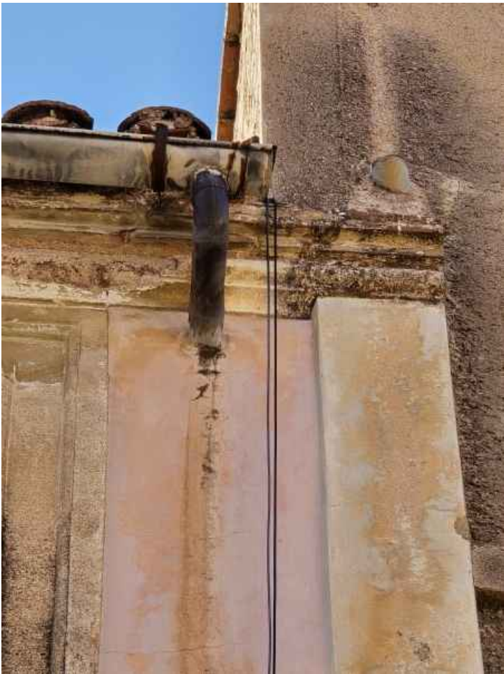
7. RECOLLIDA D'AIGÜES PLUVIALS. SUBSTITUCIÓ DEL CANALÓ I ARRANJAMENT DE CORNISES I MOTLLURES
