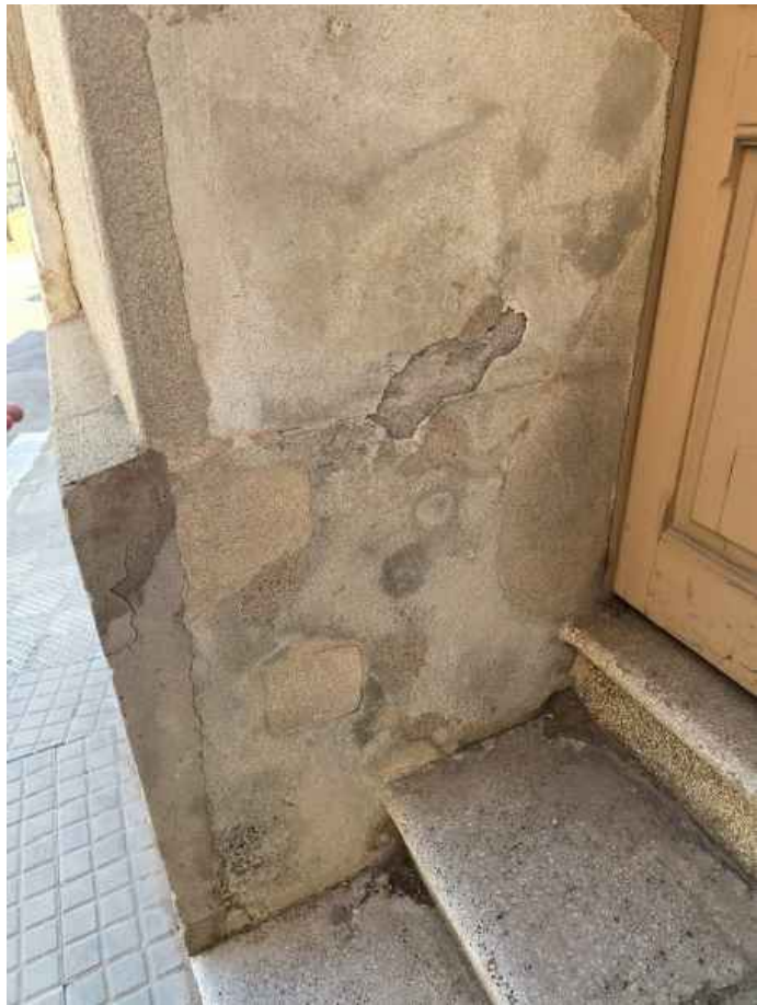
1. 2. 3. ABOMBAMENT, TRENCAMENT I DESPRENIMENT DE LA CAPA DE MORTER DE CALÇ ORIGINÀRIA. ES POT OBSERVAR QUE HA ESTAT REPARADA PER TAL D'EVITAR CAIGUDA D'OBJECTES A LA VIA.
