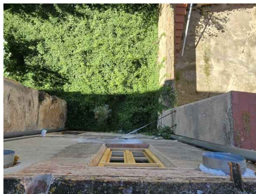
5. FAÇANA POSTERIOR. REHABILITACIÓ DE TOTA LA FAÇANA
