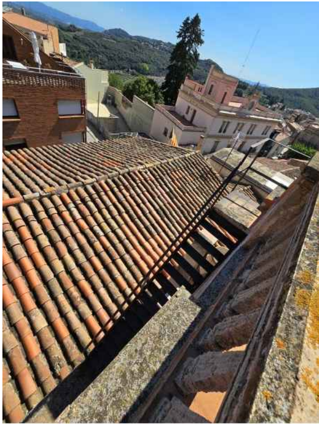
2. ACCÉS A COBERTA TORREÓ. VISTA DE COBERTA INCLINADA A DUES AIGUES.
