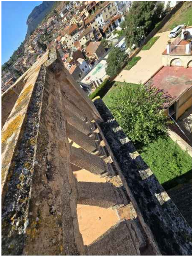
3. BALUSTRADE TORREÓ. CAL INTERVENCIÓ EN REPOSICIÓ DE PECES I REPARACIÓ DE PASSAMÀ I CORNISES
