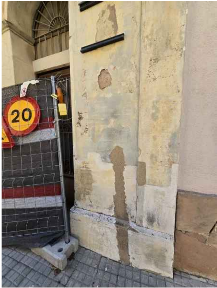
4. 5. 6. ABOMBAMENT, TRENCAMENT I DESPRENIMENT DE LA CAPA DE MORTER DE CALÇ ORIGINÀRIA. ES POT OBSERVAR QUE HA ESTAT REPARADA PER TAL D'EVITAR CAIGUDA D'OBJECTES A LA VIA.
