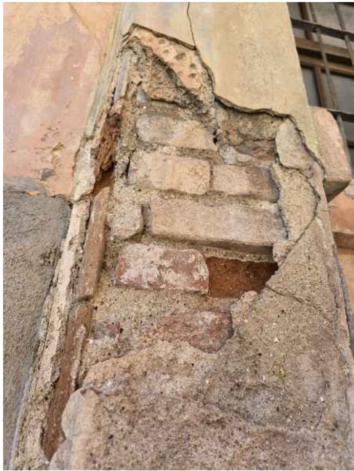
4. 5. 6. ABOMBAMENT, TRENCAMENT I DESPRENIMENT DE LA CAPA DE MORTER DE CALÇ ORIGINÀRIA. ES POT OBSERVAR QUE HA ESTAT REPARADA PER TAL D'EVITAR CAIGUDA D'OBJECTES A LA VIA.
