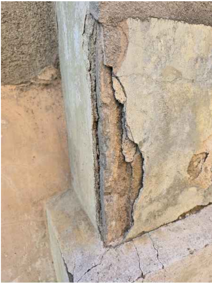
4. 5. 6. ABOMBAMENT, TRENCAMENT I DESPRENIMENT DE LA CAPA DE MORTER DE CALÇ ORIGINÀRIA. ES POT OBSERVAR QUE HA ESTAT REPARADA PER TAL D'EVITAR CAIGUDA D'OBJECTES A LA VIA.
