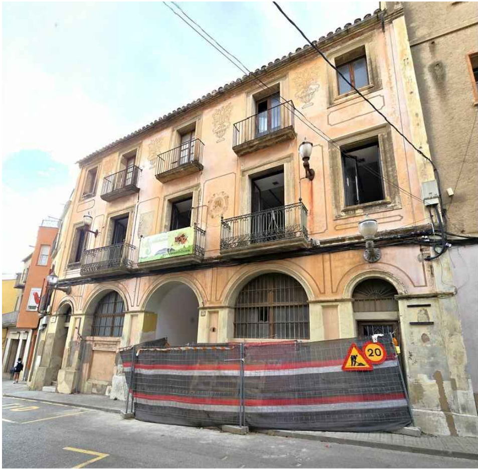
2. FAÇANA CARRER VIC 1
