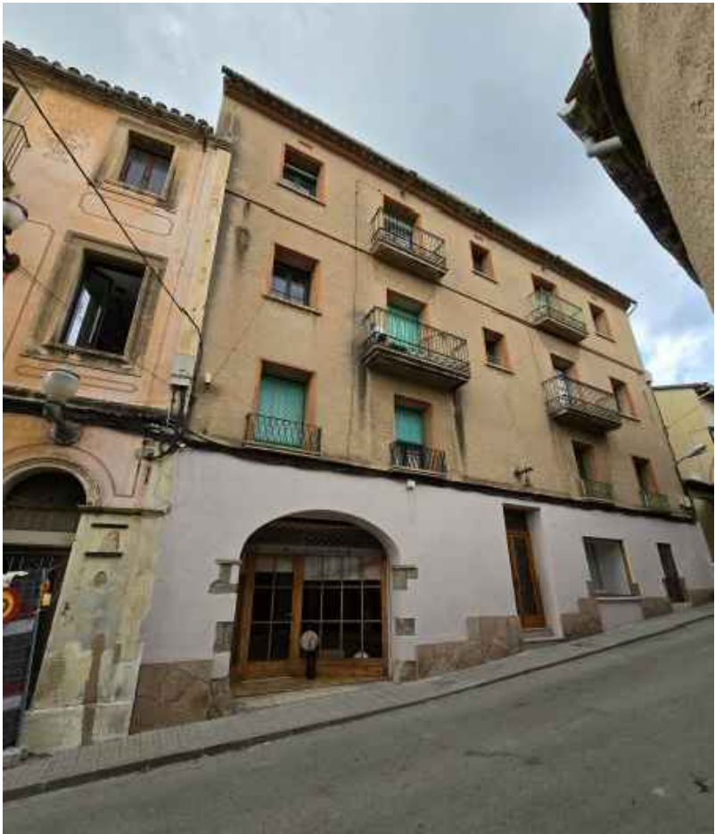
3. FAÇANA CONLINDANT DRETA
