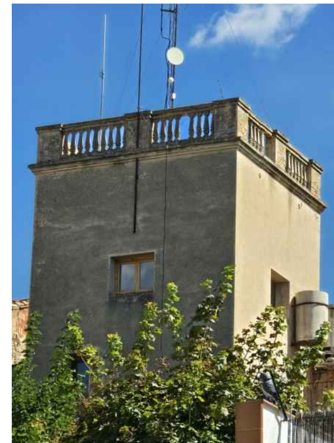
6. TORREÓ. REHABILITACIÓ DE FAÇANES, ARRANJAMENT DE BALUSTRADES, REPARACIÓ DE CORNISES.
