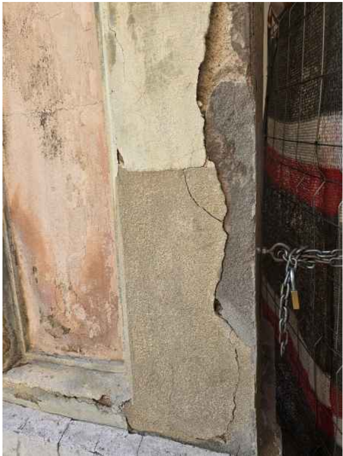
1. 2. 3. ABOMBAMENT, TRENCAMENT I DESPRENIMENT DE LA CAPA DE MORTER DE CALÇ ORIGINÀRIA. ES POT OBSERVAR QUE HA ESTAT REPARADA PER TAL D'EVITAR CAIGUDA D'OBJECTES A LA VIA.
