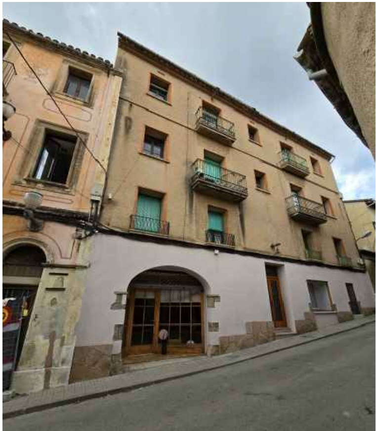
5. FAÇANA CARRER VIC, FINCA VEÏNA PEL SUD-EST.
