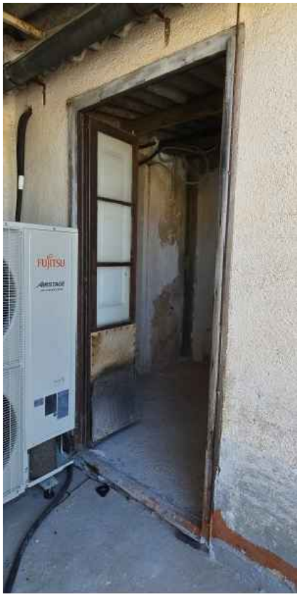
1. FUSTERIES EXTERIORS DE FUSTA, NO ESTANQUES, VIDRES TRENCATS I MAL CONSERVADES. CAL SUBSTITUCIÓ SEGUINT MATEIXOS CRITERIS ESTÈTICS.
