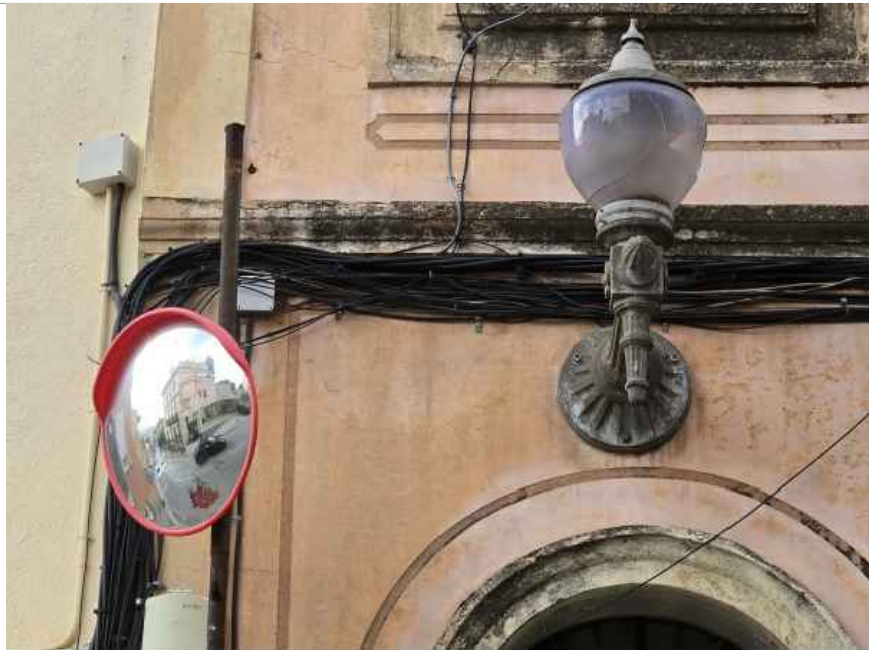
1. FANAL AMB VIDRE TRENCAT I ELEMENTS ADOSATS A FAÇANA
