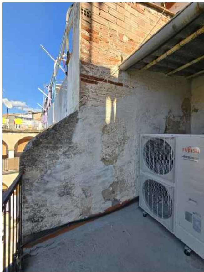
1. TERRASSA POSTERIOR 2. FAÇANA A REHABILITAR
