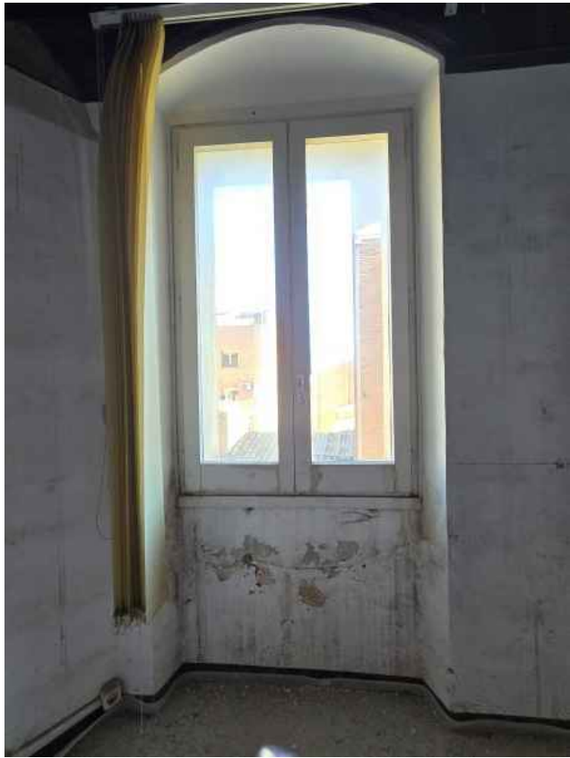
1. FUSTERIES EXTERIORS DE FUSTA, NO ESTANQUES, VIDRES TRENCATS I MAL CONSERVADES. CAL SUBSTITUCIÓ SEGUINT MATEIXOS CRITERIS ESTÈTICS.
