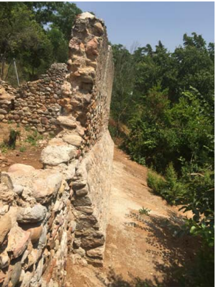
9 Vista de la base del mur consolidat i reforçat (espai 7)
