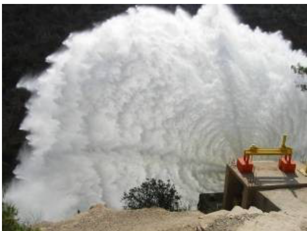
Amplitud del xorro de descàrrega en vàlvules de xorro buit.
