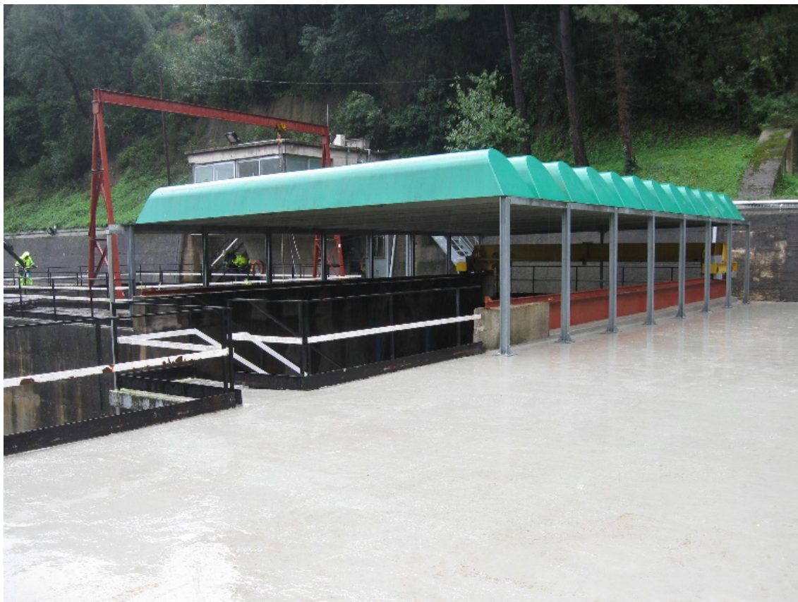
COBERTA A DESMUNTAR
