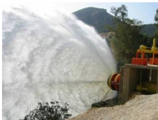
Amplitud del xorro de descàrrega en vàlvules de xorro buit.
