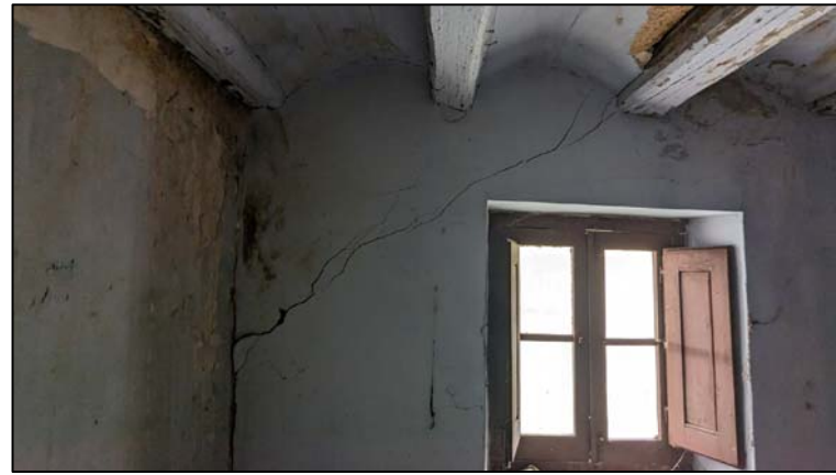
FOTO 01: CANTONADA FAÇANA POSTERIOR
