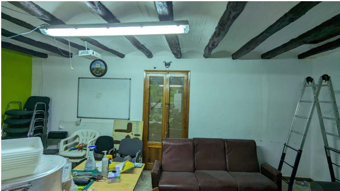
Foto 05: Vista interior obertura a façana principal de biguetes forjat sostre planta primera a reforçar
