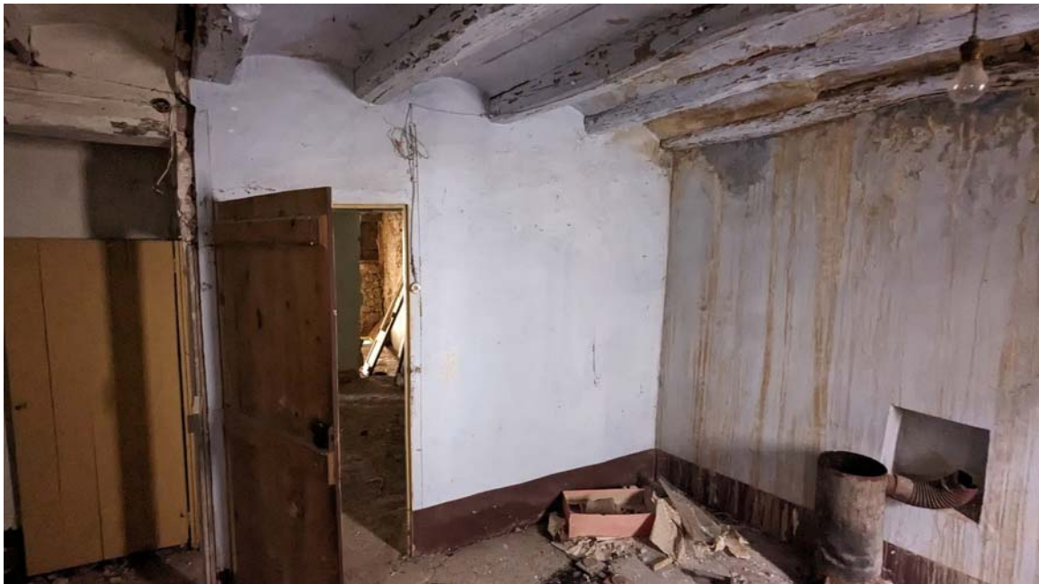
Foto 10: Vista actual interior distribució Planta Segona: envans i sostre a enderrocar
