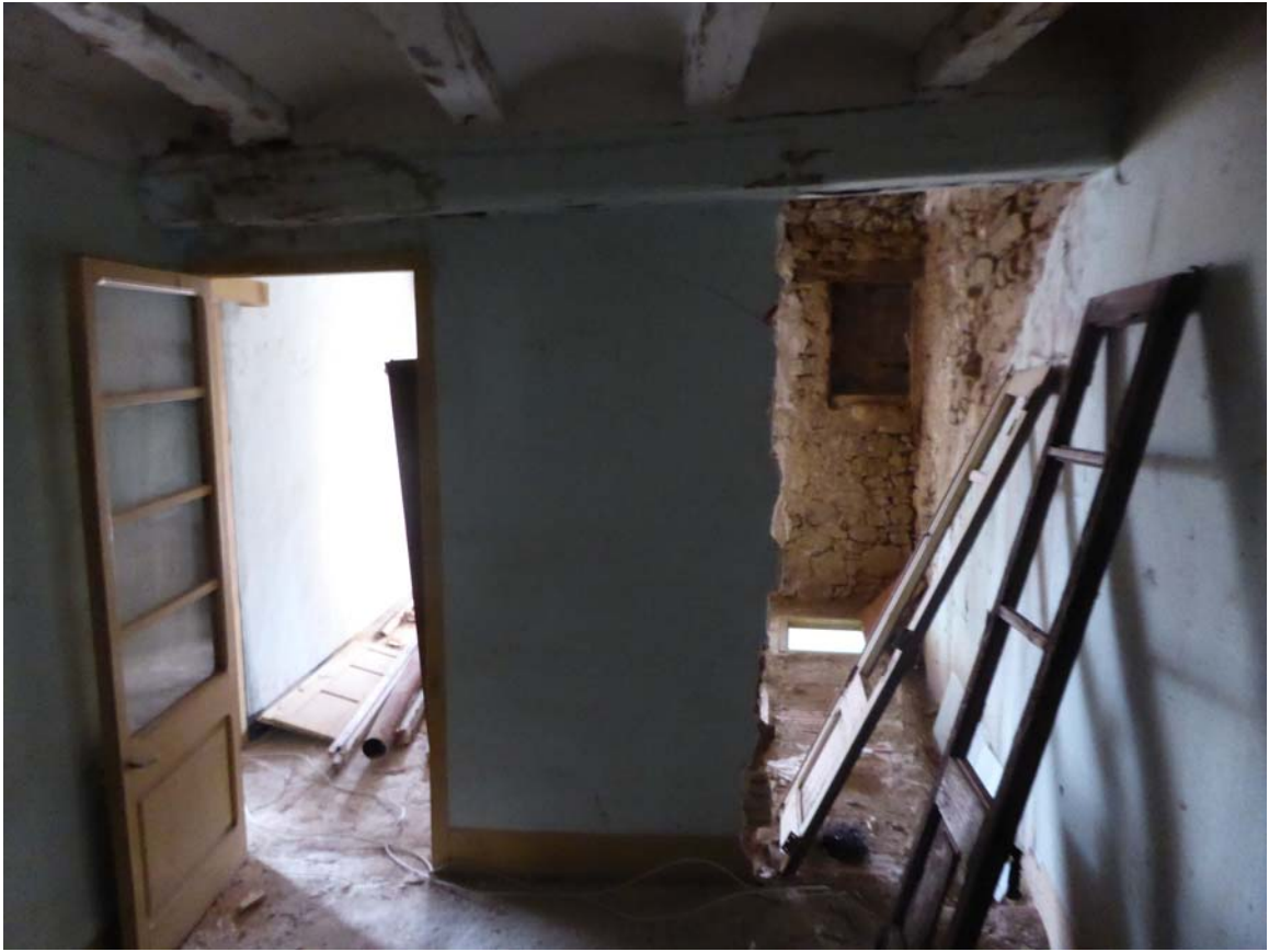
Foto 11: Vista actual interior distribució Planta Segona: envans i sostre a enderrocar
