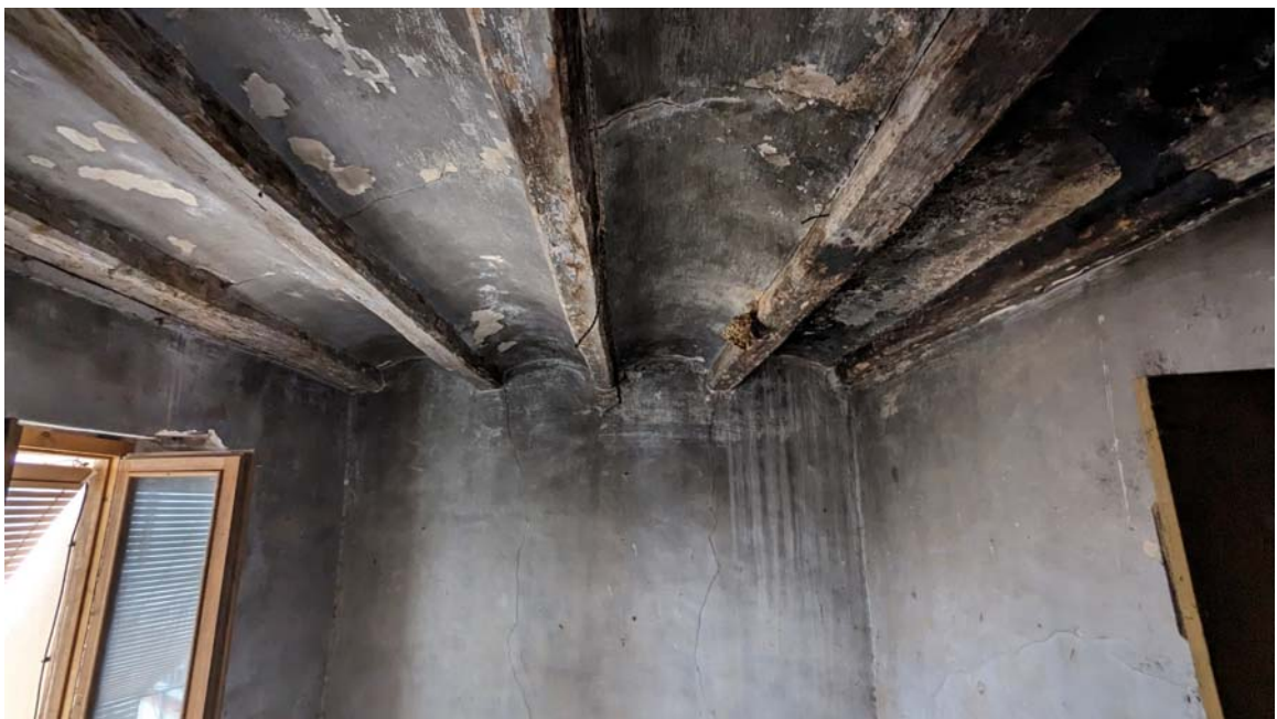
Foto 12: Vista actual sostre planta segona (entresolat) a enderrocar
