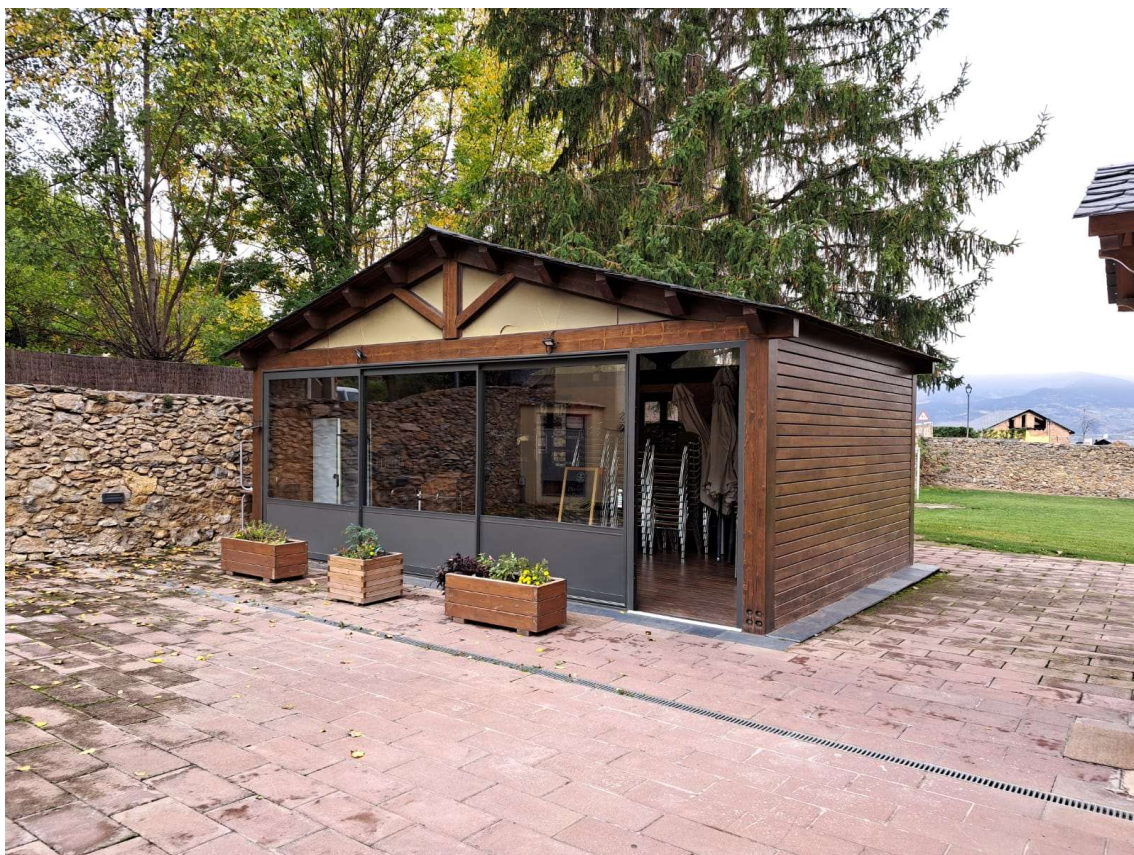
FOTOGRAFIES DE L'ESTAT ACTUAL. ZONA EXTERIOR.
