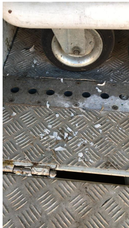
Ferm del terra de la deixalleria.
