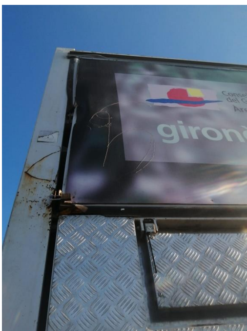
Portes d'obertura i tancament
