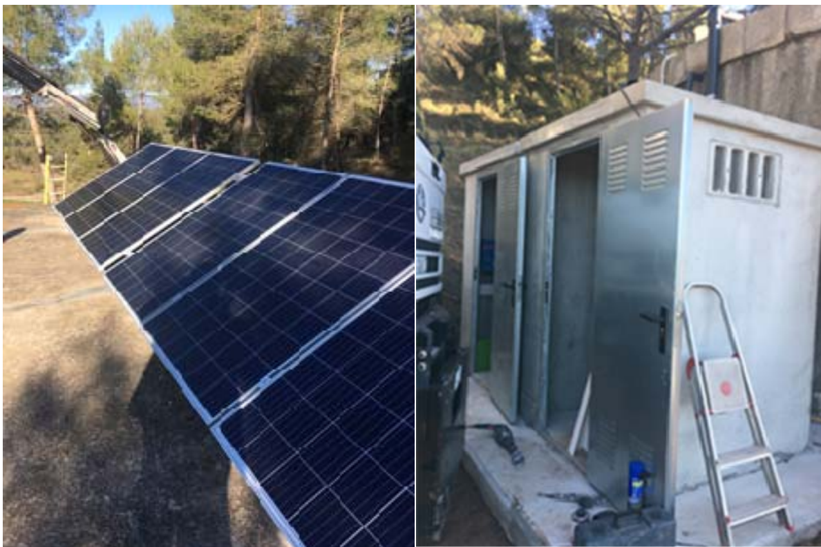
Imatge dels captadors solar fotovoltaics i de les casetes prefabricades per allotjar el clorador.
