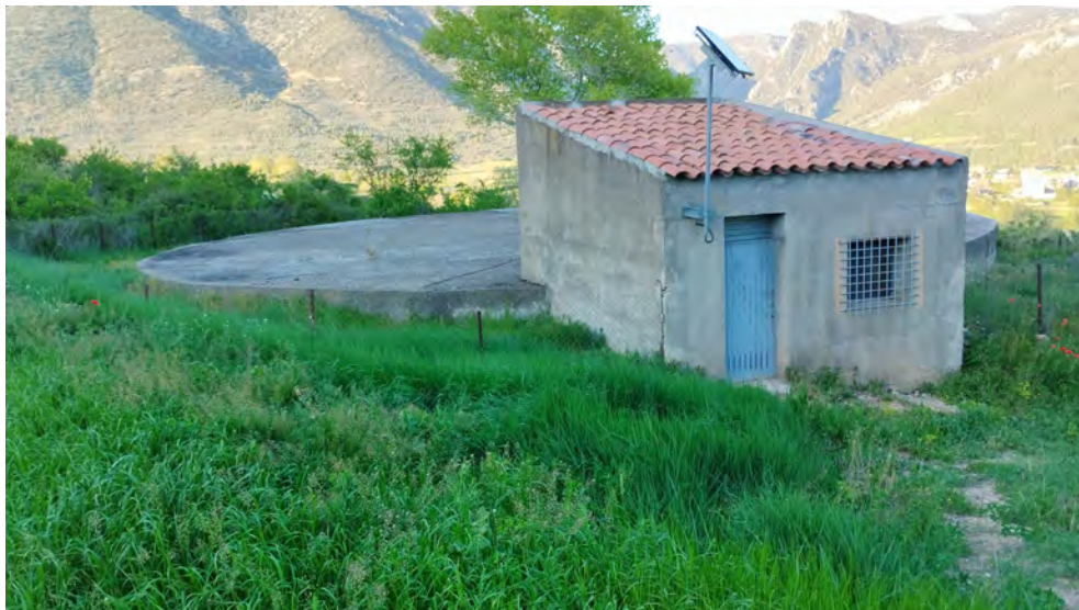
Caseta de vàlvules del dipòsit de 1.000 m³
