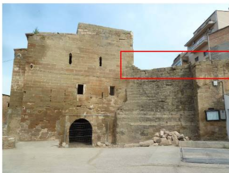
Fotografia: estat actual sense l'antiga granja però encara amb les restes del dipòsit en coberta que caldrà desmuntar
