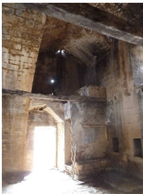
Arc i voltes rebaixades laterals
