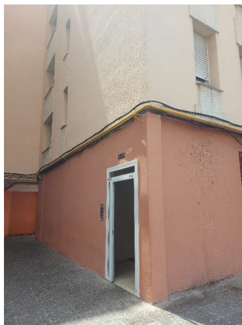
*Façana est de l'edifici 8B.
