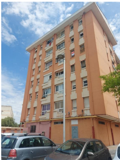
*Façana oest de l'edifici 8A.
