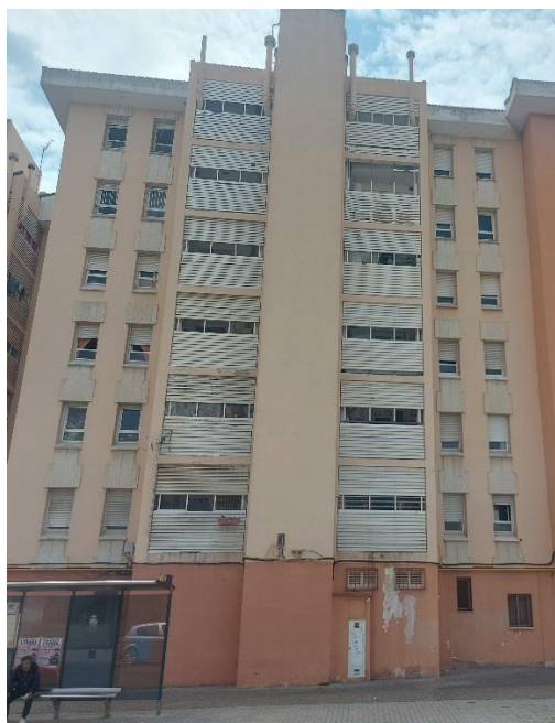
*Façana nord de l'edifici 8B.
