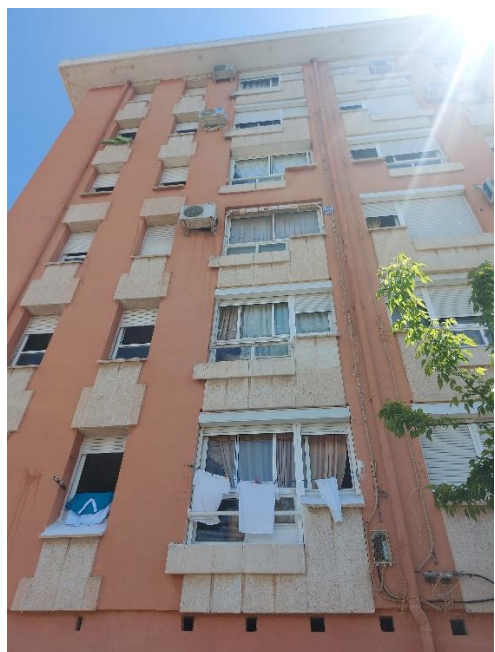
*Façana oest de l'edifici 8A.
