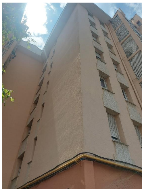
*Façana est de l'edifici 8B.
