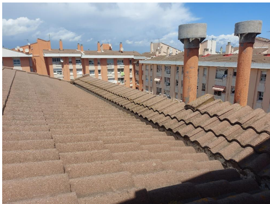
*Coberta inclinada 1 de l'edifici 8H.
