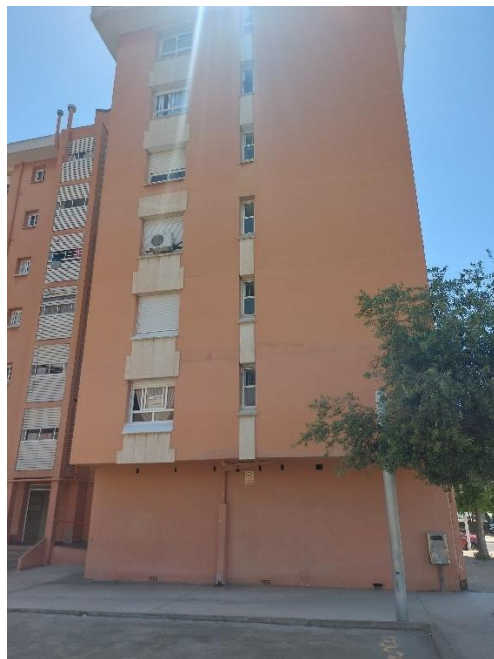
*Façana nord de l'edifici 8H.
