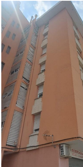
*Façana secundària est de l'edifici 8A.
