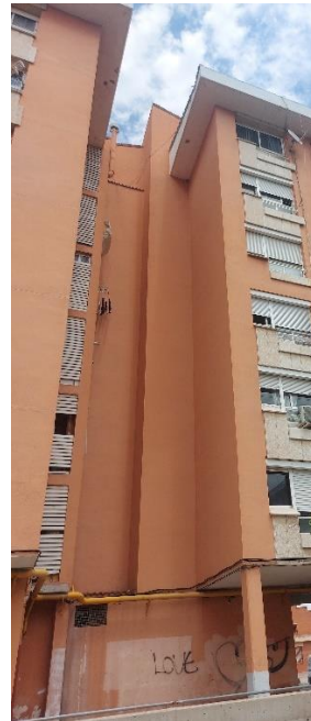
*Façana secundària oest de l'edifici 8A.
