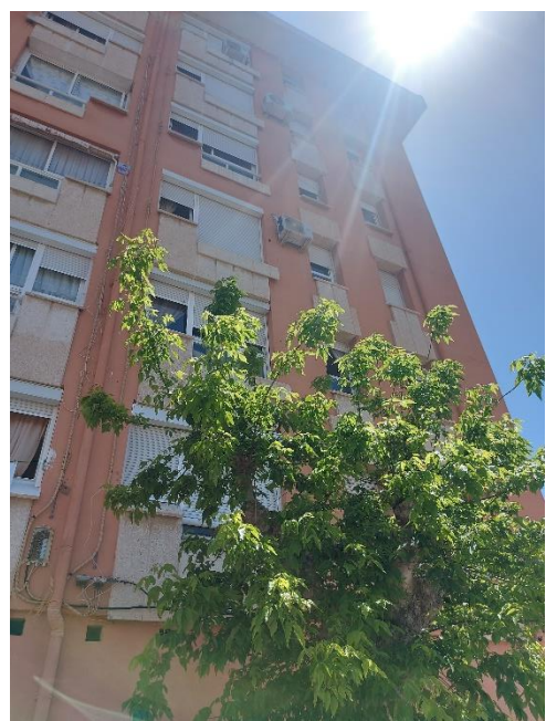
*Façana oest de l'edifici 8A.
