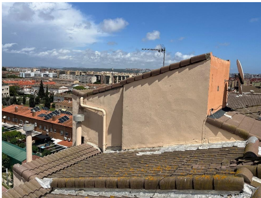
*Coberta inclinada 2 de l'edifici 8A.
