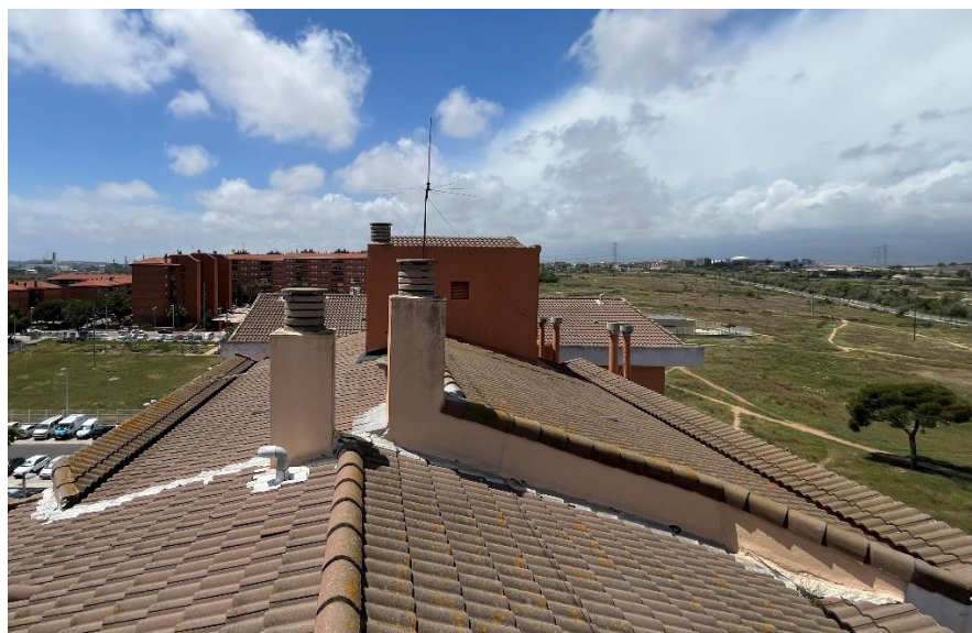
*Cobertes inclinades 1, 2, 3 i 4 de l'edifici 8A.
