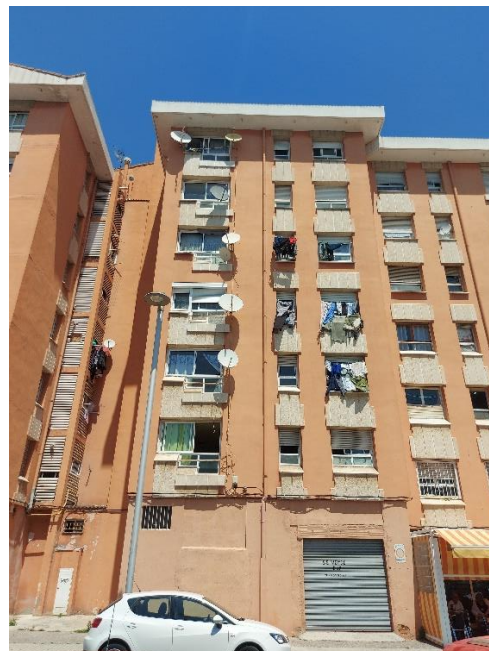
*Façana sud de l'edifici 8H.
