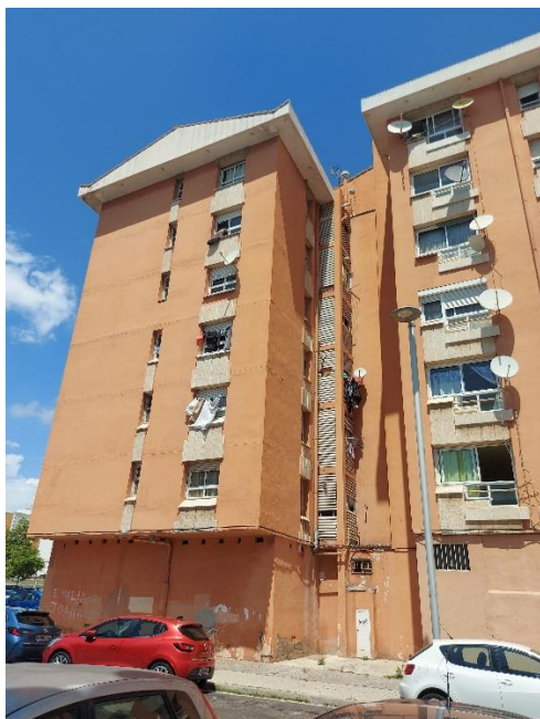
*Façana sud de l'edifici 8H.
