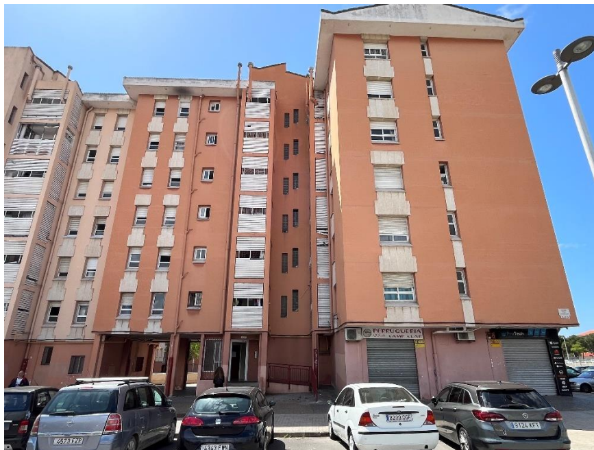
*Façana nord de l'edifici 8A.
