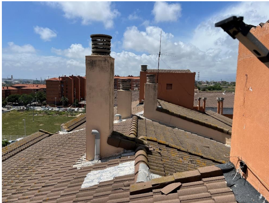
*Coberta inclinada 1 de l'edifici 8A.
