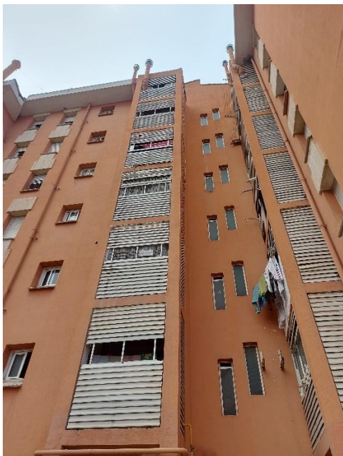
*Façana nord de l'edifici 8H.
