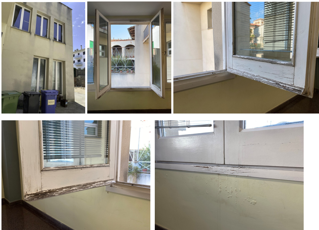
Fotografies estat actual fusteria façana nord
