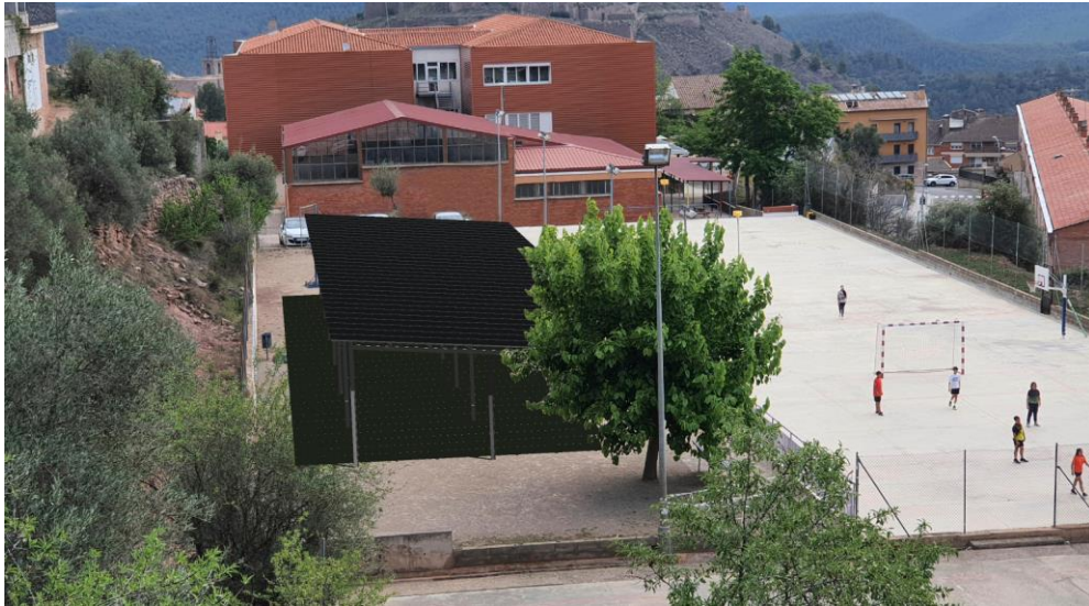
Instal·lació coplanar sobre pèrgola
