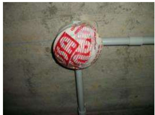
Foto 1.20- Detector obstruido con cinta de precinto.
