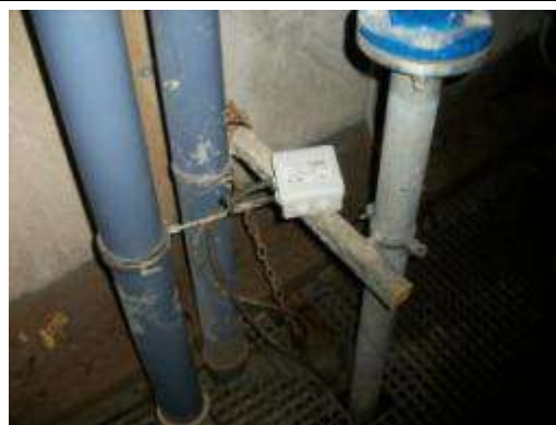
Foto 2.23 – Foso de bombas, caja de conexiones fijada con bridas.
