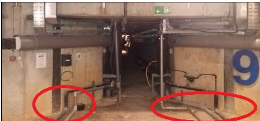
Imagen 8. Tuberías a nivel del suelo, en zona de paso.
