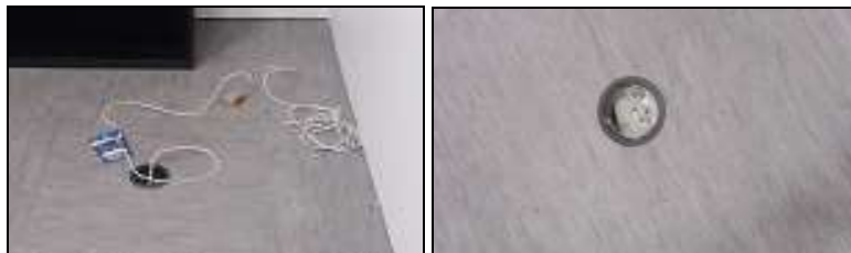
Imagen 3. Aberturas en el suelo técnico
