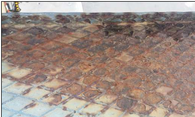
Imagen 16. Oxidación de la escalera de acceso.
