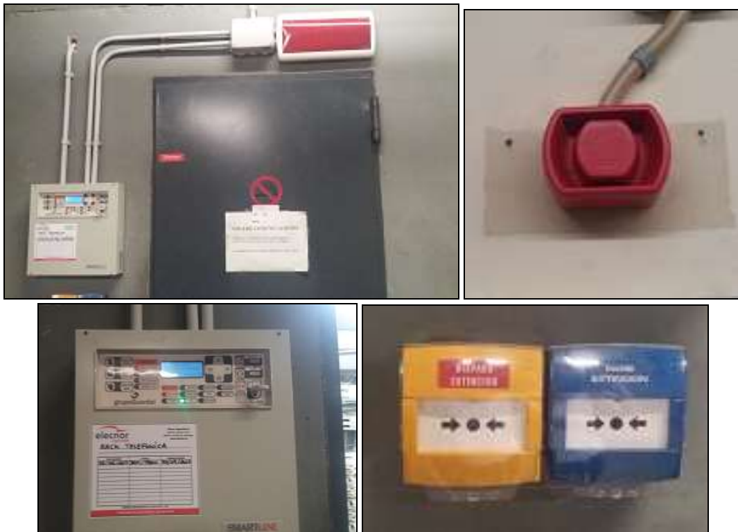
Imagen 22. Sistema fijo de extinción de incendios instalado en la sala de comunicación.
