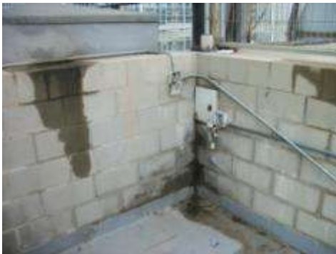
Foto 3.9 – Cajas de conexiones abiertas y en mal estado.
