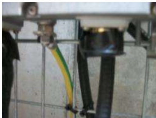
Foto 6.16 – Posibles partes activas de la instalación de telefonía protegidas con cinta aislante
