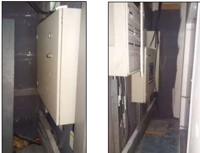
Imagen 10. Cuadro eléctrico dentro del armario.
