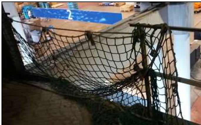
Imagen 1. Red vertical incorrectamente colocada.
