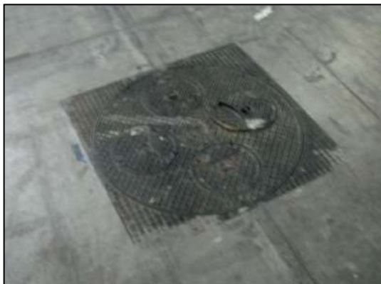
Imagen 2. Ejemplo de arqueta de suministro eléctrico.
