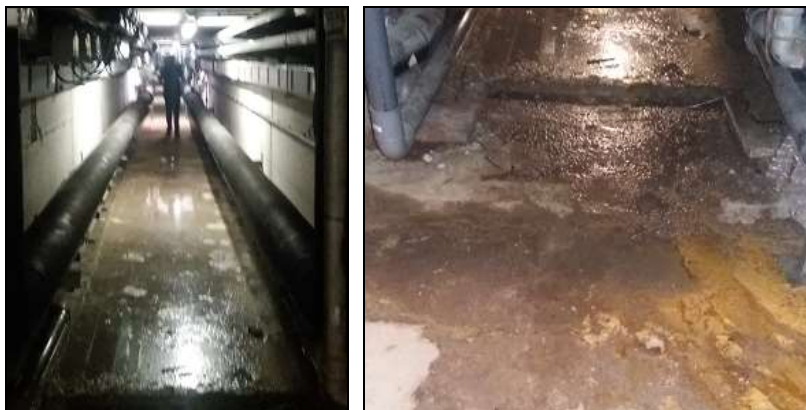
Imagen 15. Presencia de agua en los pasillos de las galerías.
