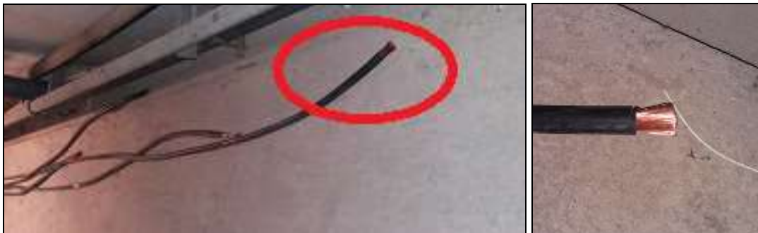
Imagen 33. Cable pelado sin tensión.
