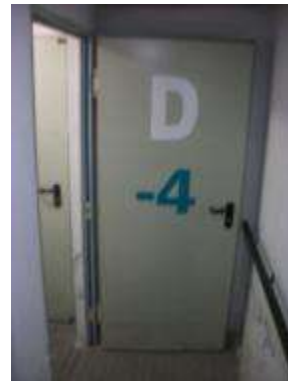
Foto 4.21 – Puerta sin sistema de autocierre.
