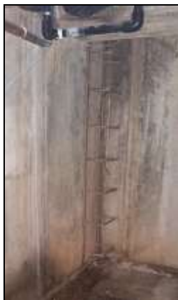
Imagen 3. Escala vertical integrada en la pared (Vista inferior)
