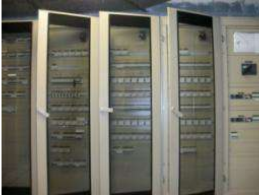
Foto 5.15 – Cuadros abiertos sin señalizar
