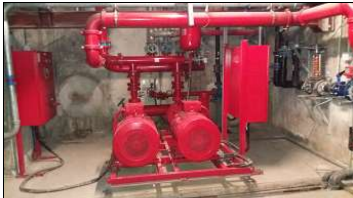
Imagen 23. Sistema fijo de extinción de incendios ubicado en la galería del pabellón 2.
