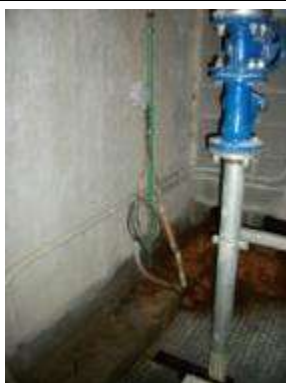
Foto 2.22 – Foso de bombas, caja de conexiones fijada con bridas
