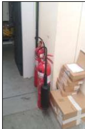
Imagen 26. Extintor CO 2 sin revisión en fecha.
