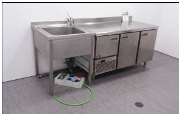
Imagen 7. Caja cableada bajo el fregadero de la cocina
