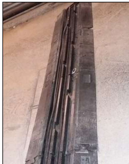
Imagen 10. Canalizador de cables sin protección.
