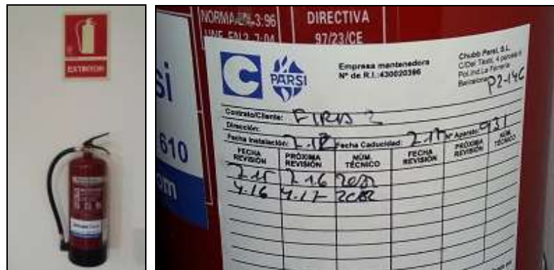
Imagen 14. Extintor caducado junto a la sala técnica ST8
