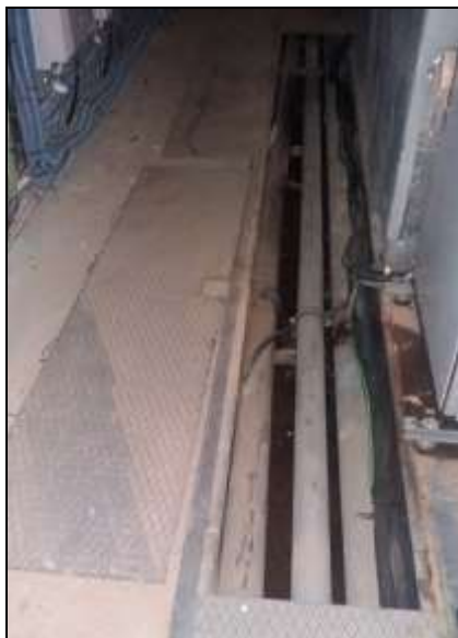
Imagen 6. Placa fuera de lugar. Huevo al descubierto.
