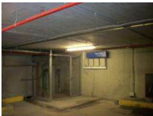
Foto 2.23 – Arquetas para bombas de drenaje
