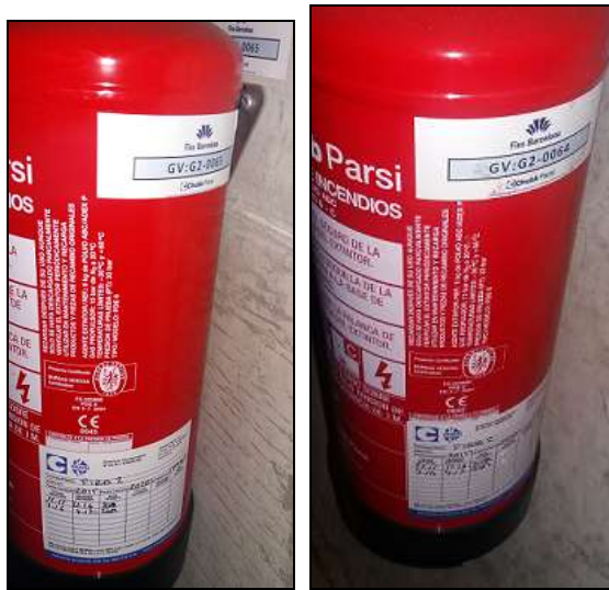
Imagen 29. Extintores sin revisión en plazo efectuada.
