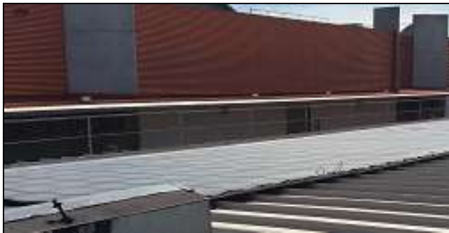
Imagen 4. Barandilla perimetral de la cubierta (lado Pabellón 3)
