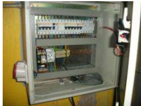
Foto 3.10 – Cuadro abierto en la zona de acceso al público y sin señalizar
