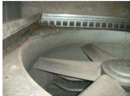
Foto 1.12 – Ventilador accesible desde la zona superior.
