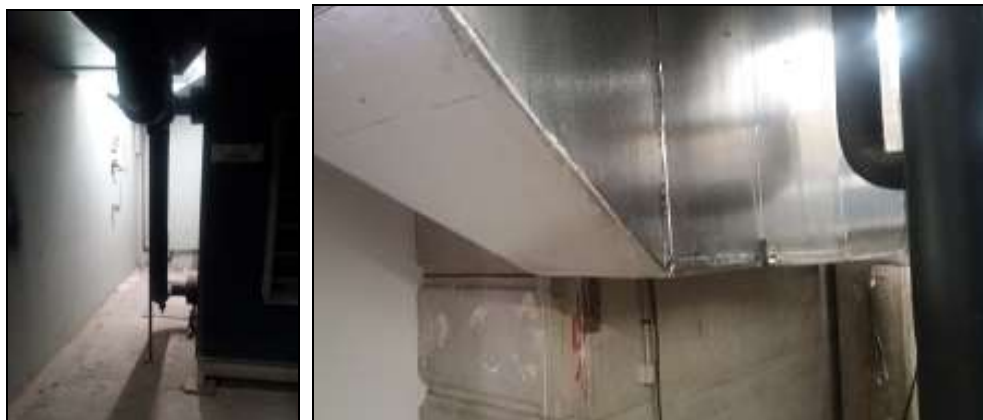
Imagen 3. Instalación de clima a baja altura en la sala técnica ST2.
