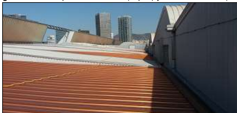
Imagen 10. Zona de paso de la ampliación sin tramex
