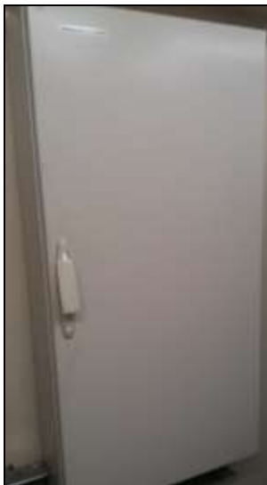
Imagen 21. Cuadro eléctrico sin señalizar.
