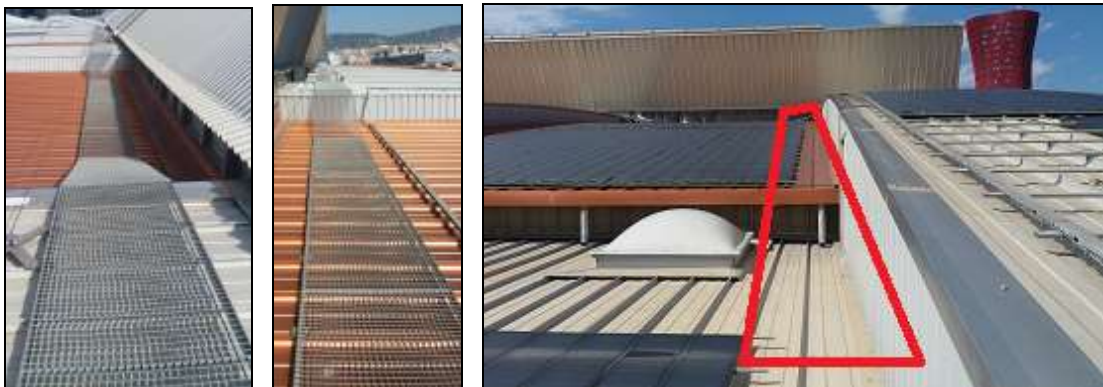
Imagen 9. Zona de paso con tramex (izqda.) y zona sin tramex (drcha.)
