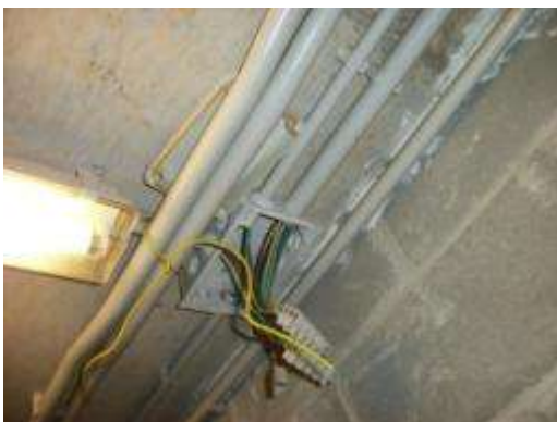
Foto 6.11 – Cajas de conexiones abiertas
