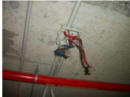
Foto 5.22 – Caja de conexiones sin envoltente de protección.
