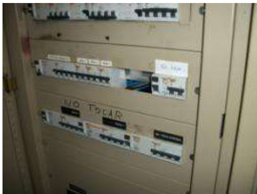
Foto 4.11 – Cuadro abierto, con huecos y sin señalizar
