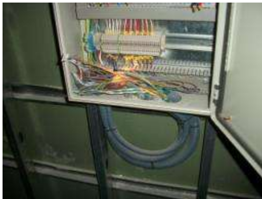
Foto 9.25 – Cuadro sin señalizar, abierto y con posibles zonas activas.
