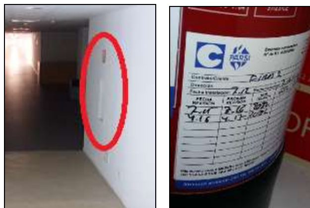
Imagen 15. 2º extintor caducado en el lobby, junto el acceso de la Espina.
