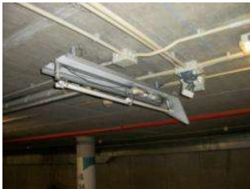
Foto 4.9 – Cajas de conexiones abiertas y señal de salida del parking en mal estado.
