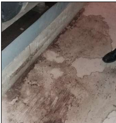
Imagen 13. Derrame de líquido de la instalación de clima.
