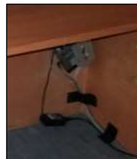
Imagen 9. Conexión eléctrica colgante
