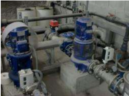
Foto 7.12 – Bomba izquierda sin resguardo de metacrilato
