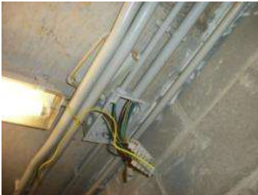
Foto 5.17 – Cuadros abiertos sin señalizar
