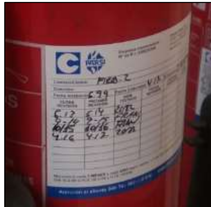
Imagen 26. Extintor CO 2 sin revisión en fecha.
