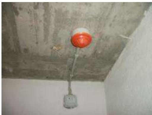
Foto 1.19.- Detector con la tapa colocada
