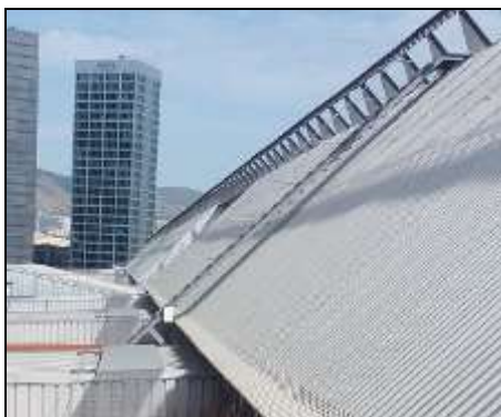
Imagen 11. Escalera de acceso a cubiertas.
