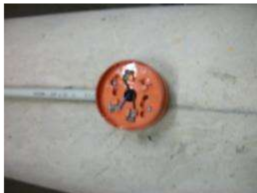
Foto 6.12 – Posible Detector desprotegido con partes activas accesibles.
