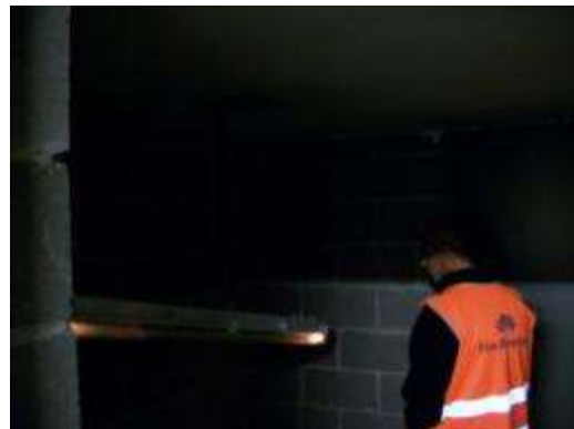
Foto 4.10 – Luminarias descolgada en la galería lateral de evacuación.
