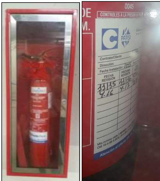
Imagen 28. Extintor cerrado y sin revisión en fecha.
