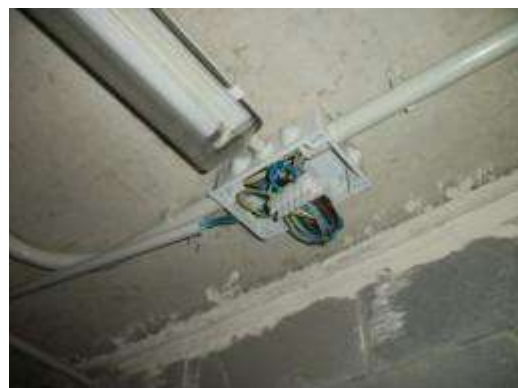
Foto 5.20 – Cajas de conexiones desprotegidas en la galería de evacuación.
