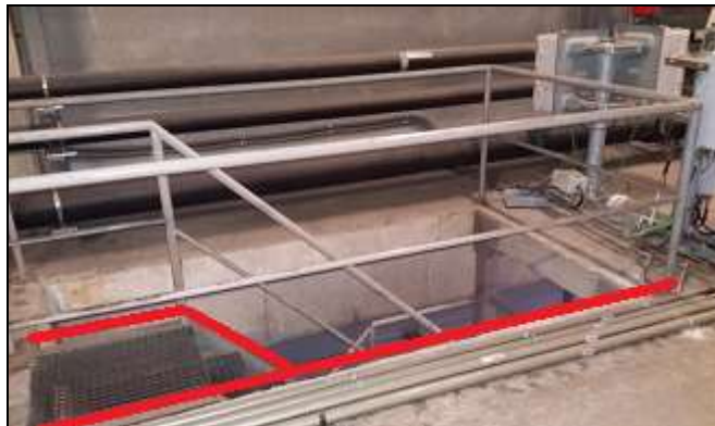
Imagen 2. Hueco entre la estructura metálica de forjado y el piso de la sala.
