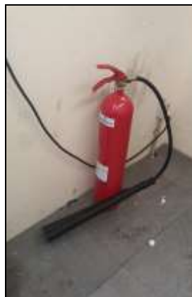
Imagen 27. Extintor CO 2 sin revisión en fecha.
