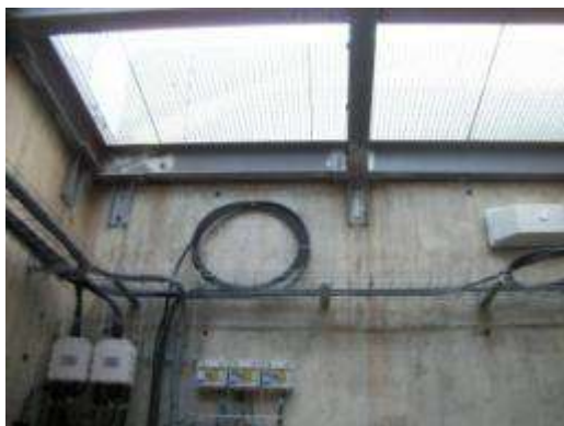
Foto 6.15 – Instalación telefonía móvil expuesta a la climatología y accesible.
