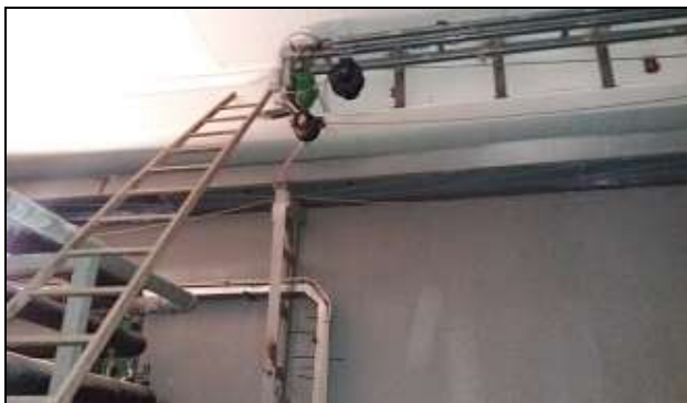
Imagen 12. Escalera de acceso al fin de carrera de la puerta de la espina.
