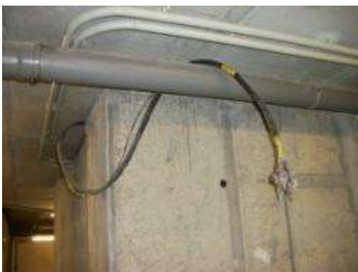
Foto 5.19 – Cables en mal estado en galerías.
