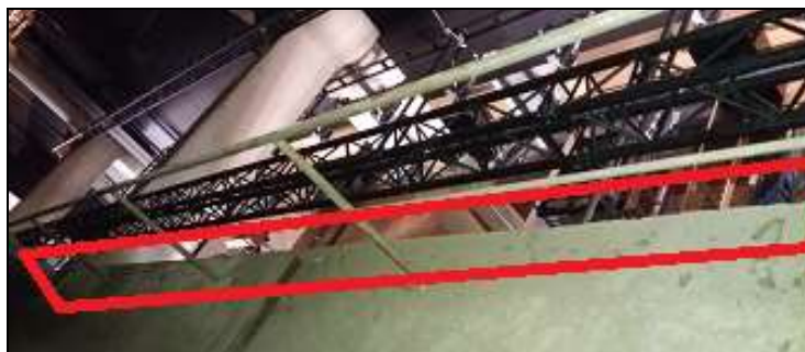
Imagen 4. 1er tramo de barandilla sin rodapiés en el altillo 2.2
