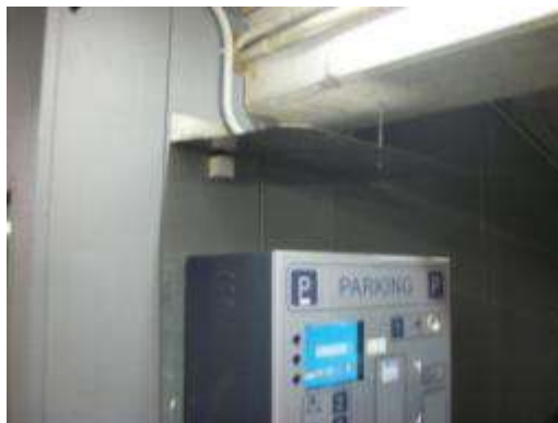
Foto 3.13 – Foto del tejadillo instalado sobre la máquina de cobro del parking para protegerla de las filtraciones de agua.
