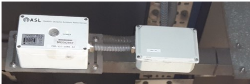
Instal·lació Sonda Dans01 a Andana estació
