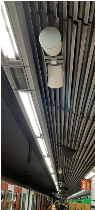
Instal·lació Projectors acústics a Andana Estació
