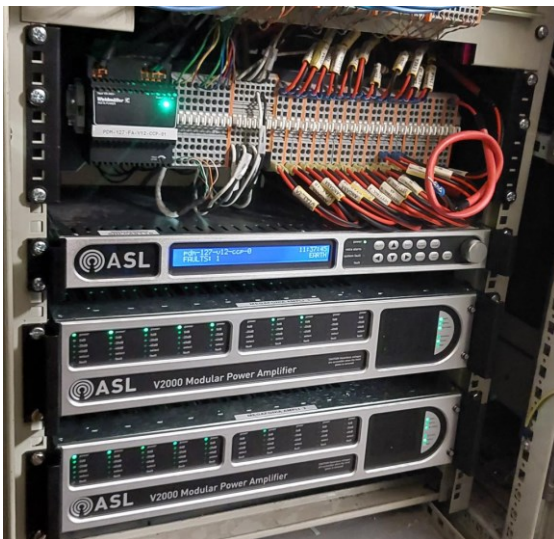
Instal·lació en rack PDM Vipedia i amplificadors V2000
