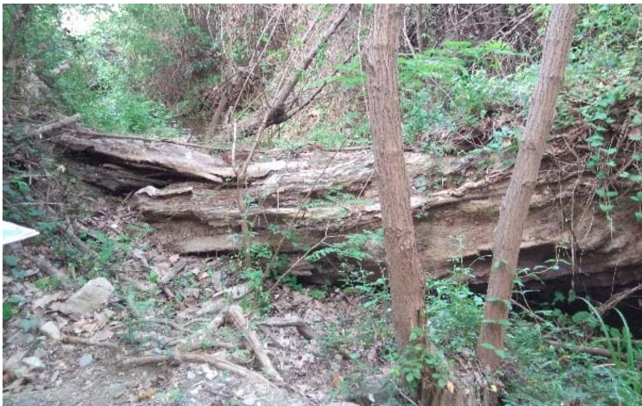
Figura 12: Vista de l'estat actual de la riera amb tronc que pot obstaculitzar el pas natural d'aigua de la riera
