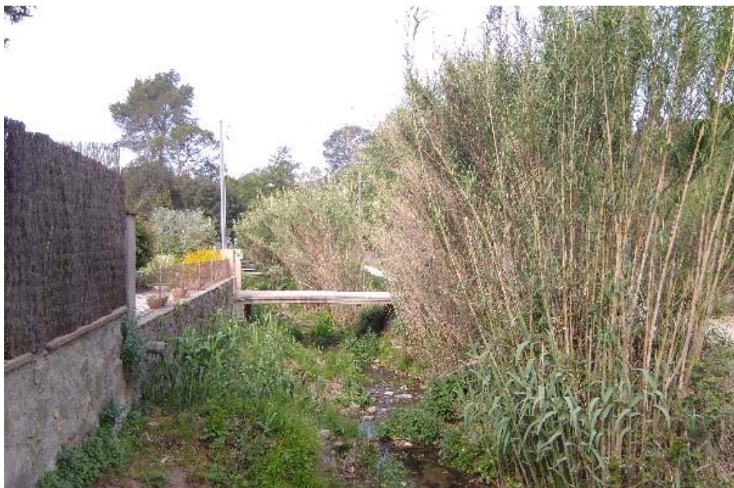
Figura 9: Vista de l'estat actual de la canya a la riera a les zones pròximes a les passeres del carrer Sibèria.
