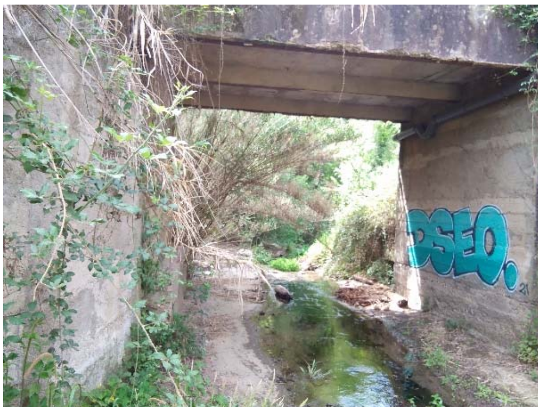
Figura 25 Pont de l'Avinguda Can Castellví
