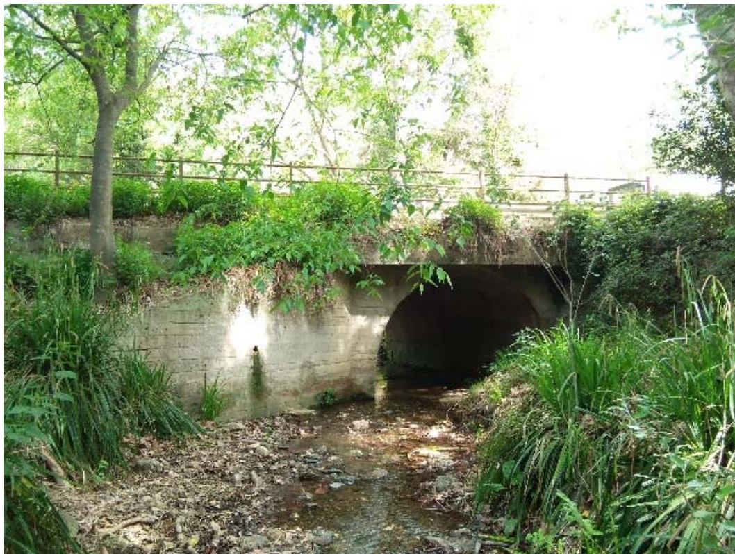
Figura 18 Pont de l'Avinguda Can Castellví
