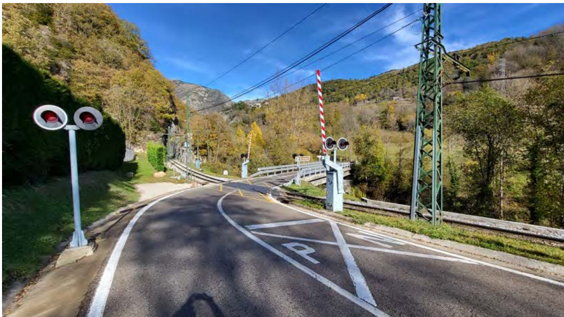
Fig 2. Vista del pas a nivell des del costat esquerre
