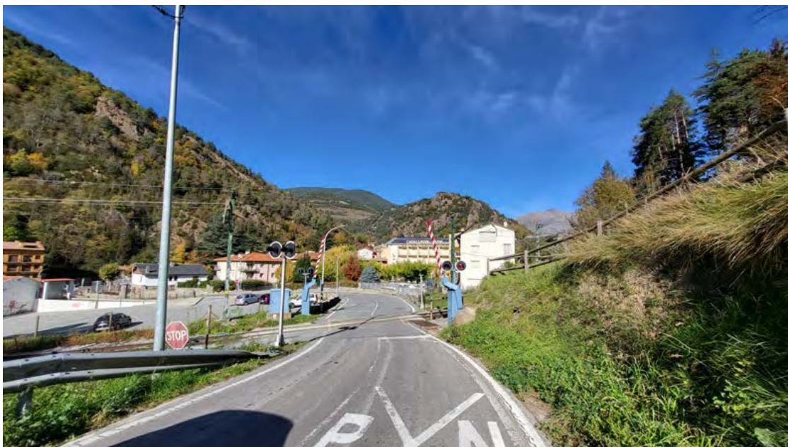
Fig 3. Vista del pas a nivell des del costat dret
