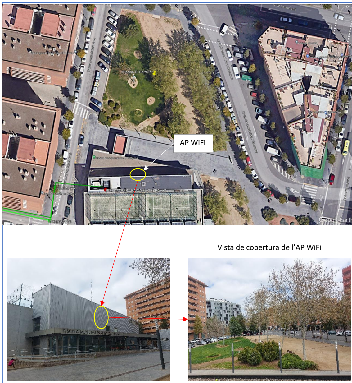
Il·lustració 8: Punt d'instal·lació de l'AP WiFi a la façana de la Piscina del Serrallo
