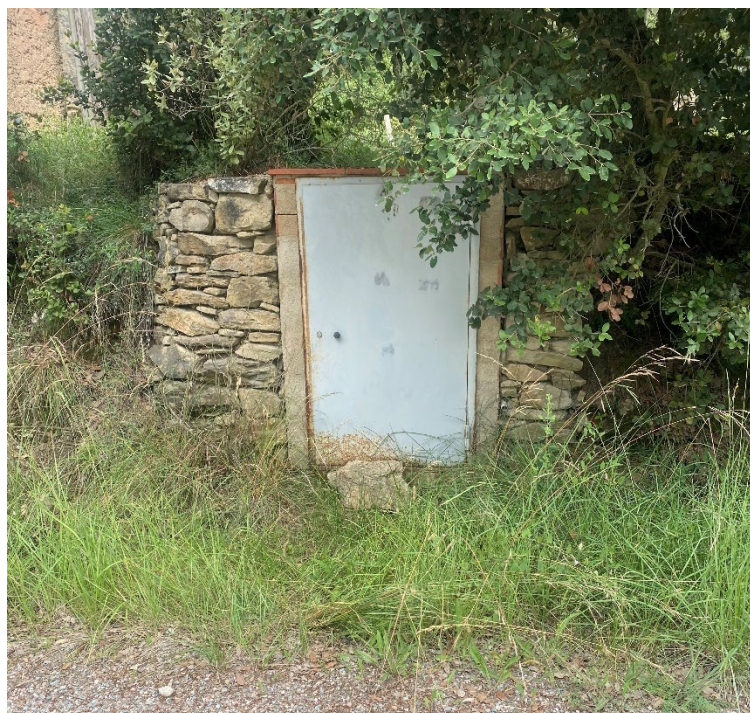
Imatge del armari de comptadors
