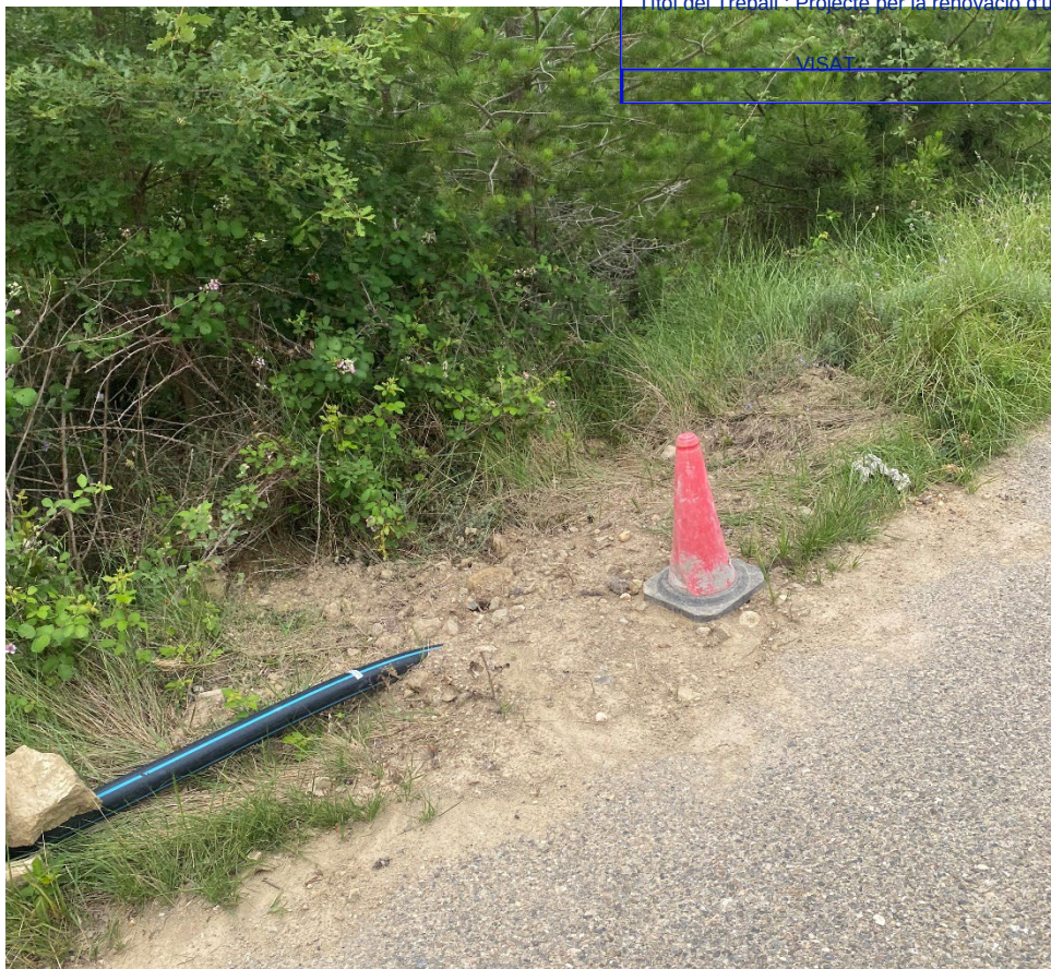
Imatge de la canonada provisional
