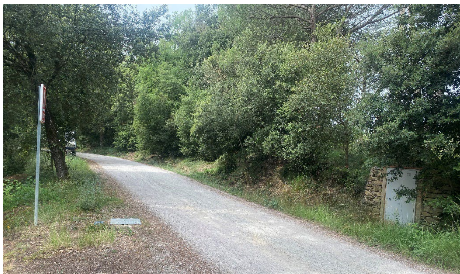
Imatge del final de línia amb hidrant clau de pas i comptadors
