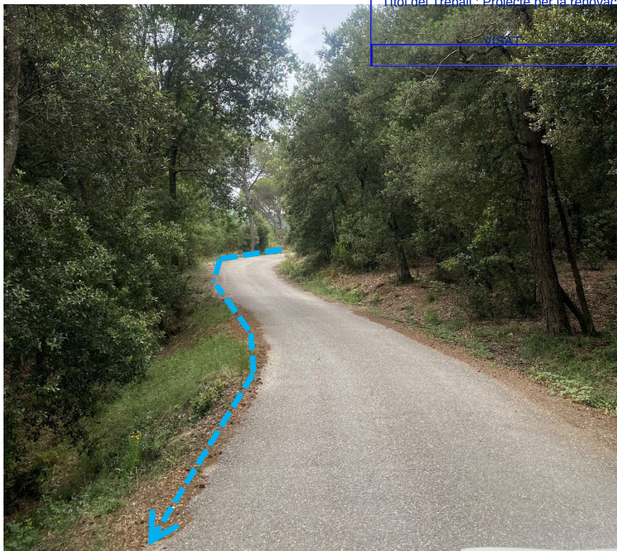
Imatge de la carretera on hi ha la canonada enterrada
