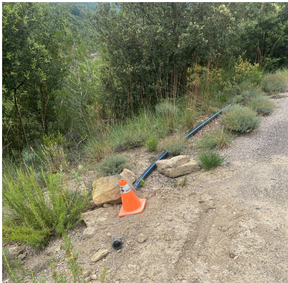
Imatge de la canonada provisional
