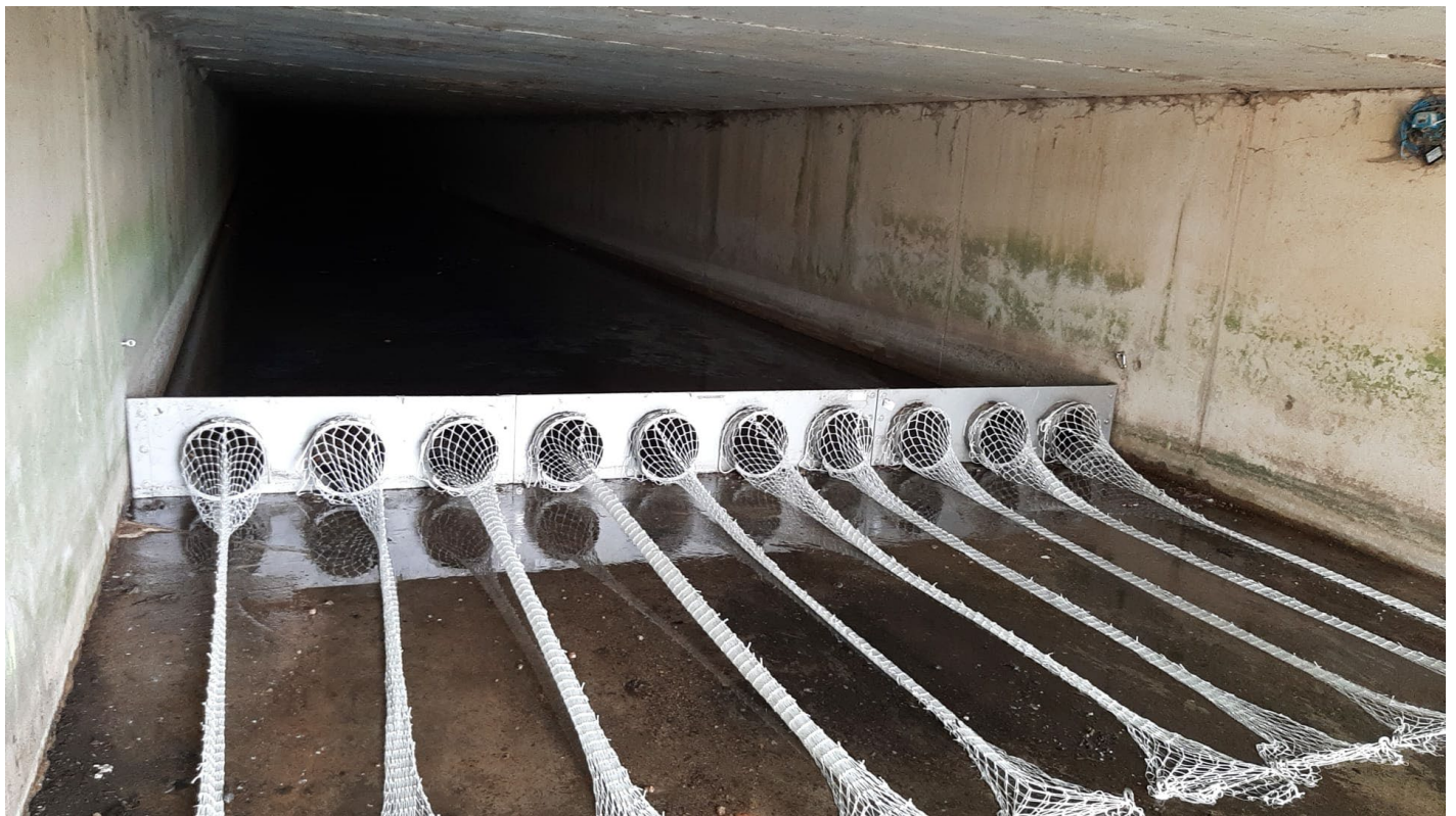
Malles retirades i substituïdes
