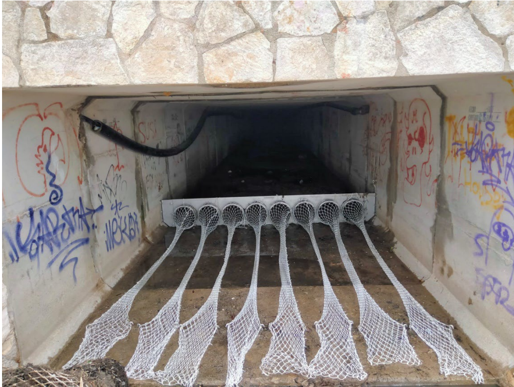
Malles retirades i substituïdes
