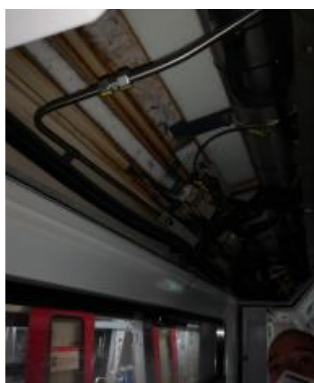
Figura 71. Instal·lació de beacon dins de capçalera (I).
