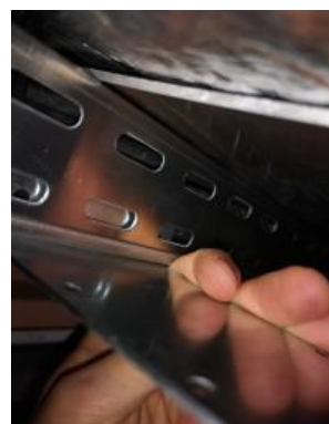
Figura 57. Instal·lació de beacon dins de capçalera (III).
