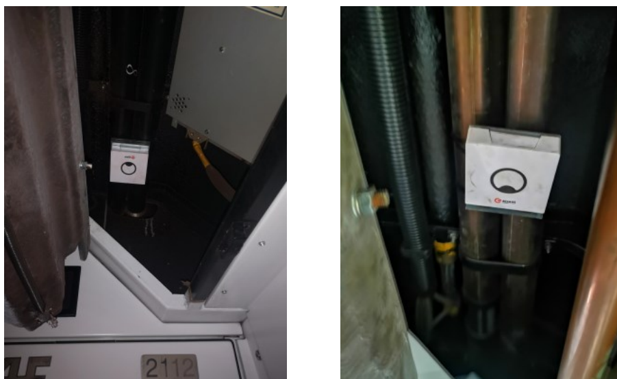
Figura 36. Instal·lació de beacon al calaix
