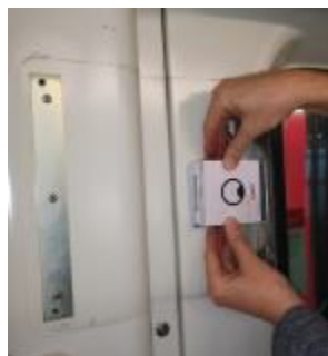
Figura 34. Instal·lació de beacon dins de panell informatiu (II).
