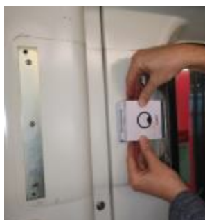
Figura 43. Instal·lació de beacon dins de panell informatiu (II).
