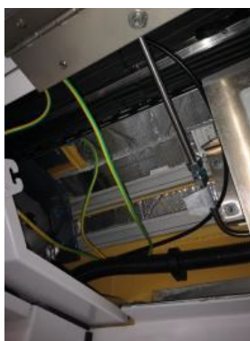
Figura 55. Instal·lació de beacon dins de capçalera (I).
