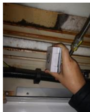
Figura 73. Instal·lació de beacon dins de capçalera (III).
