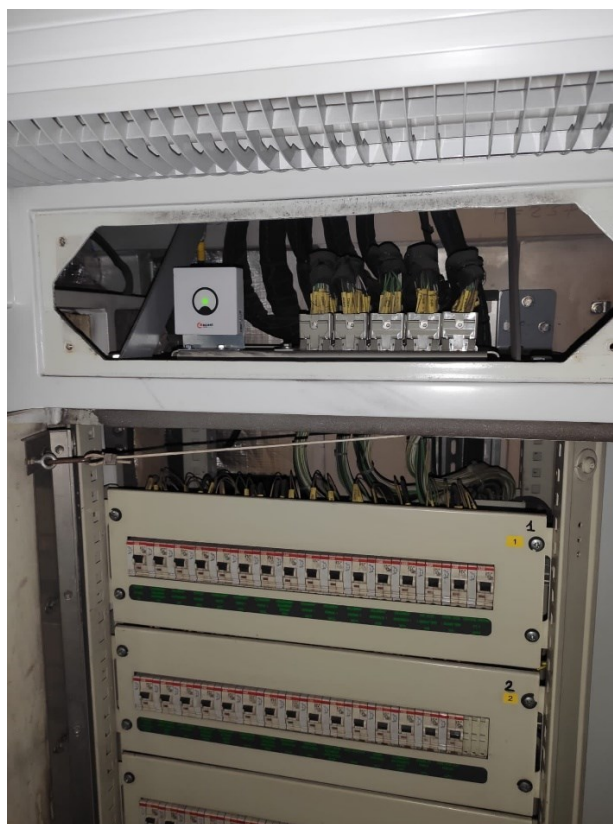
Figura 80. Resultat final de la instal·lació del beacon.
