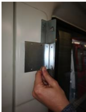
Figura 33. Instal·lació de beacon dins de panell informatiu (I).
