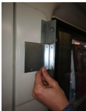
Figura 49. Instal·lació de beacon dins de panell informatiu (I).
