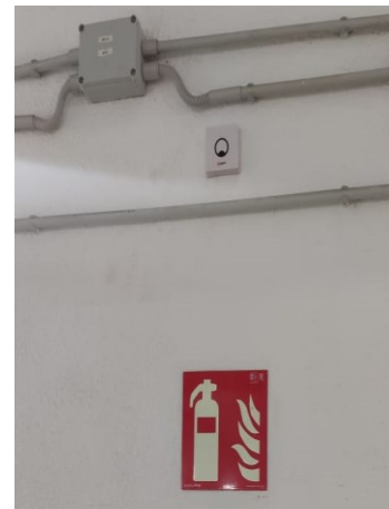
Figura 25. Exemple d'instal·lació d'un beacon a vestíbul (II).
