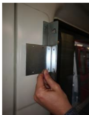
Figura 42. Instal·lació de beacon dins de panell informatiu (I).
