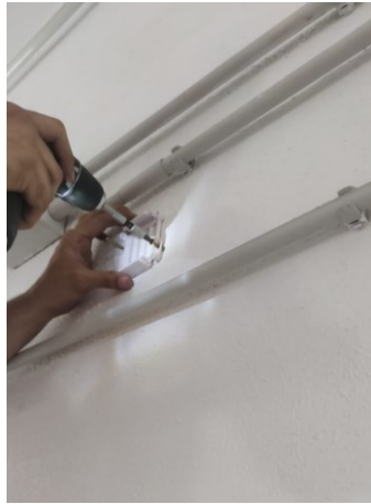
Figura 16. Instal·lació de beacon a paret (pas 1).
