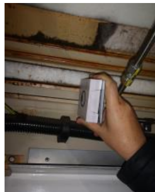
Figura 62. Instal·lació de beacon dins de capçalera (III).
