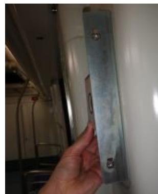
Figura 51. Instal·lació de beacon dins de panell informatiu (III).
