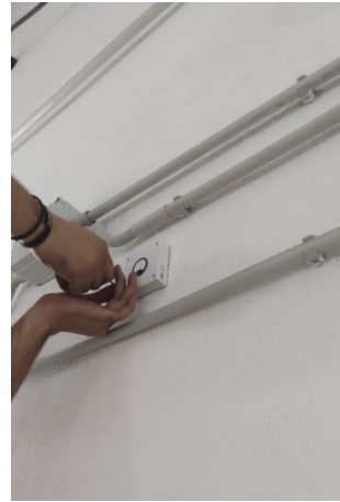
Figura 17. Instal·lació de beacon a paret (pas 2).
