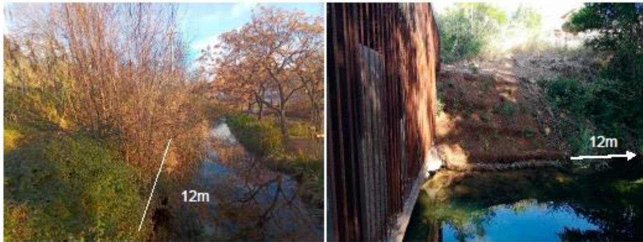
Imatges del marge dret en estat actual i l'enreixat construït al 2022
