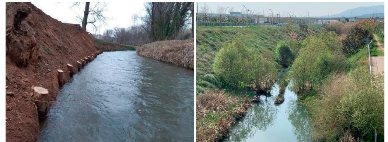
Procés constructiu d'una palissada amb troca d'arbustives
