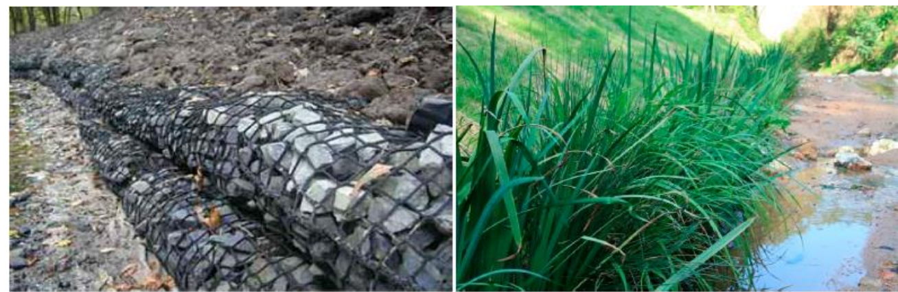
Exemples de gabions tubulars flexibles i Fiber Roll instal·lats per Naturalea
