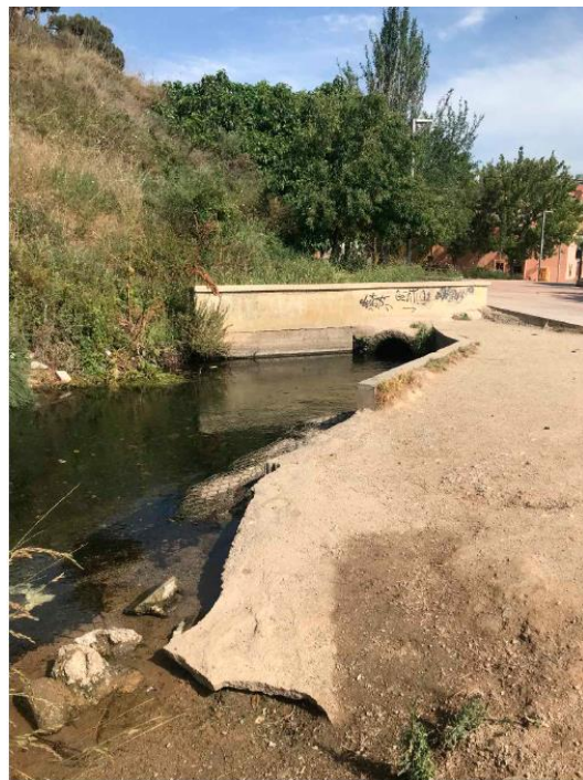
Estat abans de la intervenció 2021
