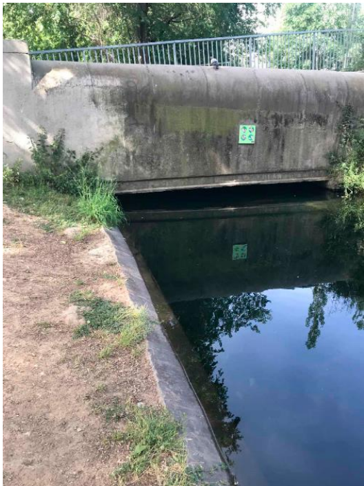
Estat abans de la intervenció 2021
