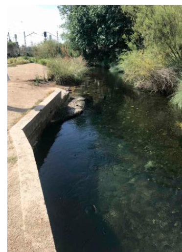
Estat abans de la intervenció 2021
