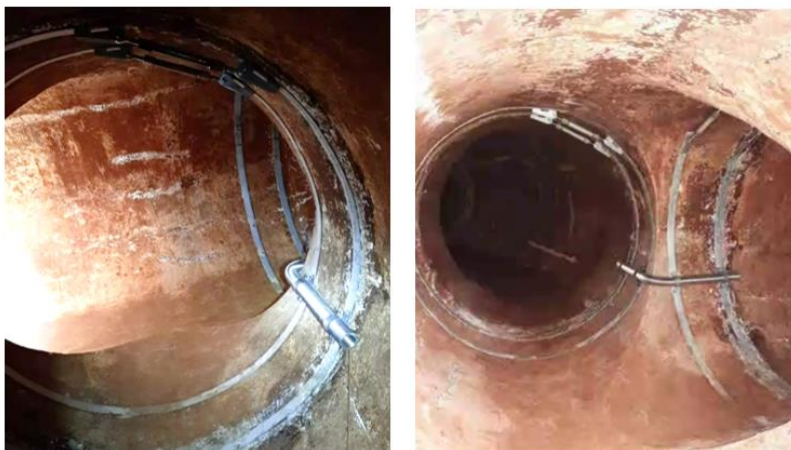
Il·lustració 3. Tub de protecció en els colzes
