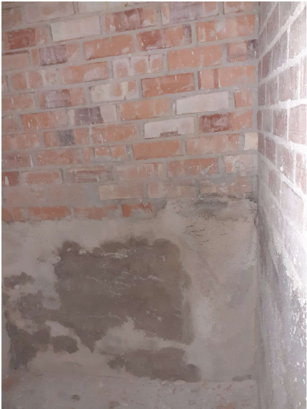
Fotografia 1. Foso i forat de l'ascensor existent.
