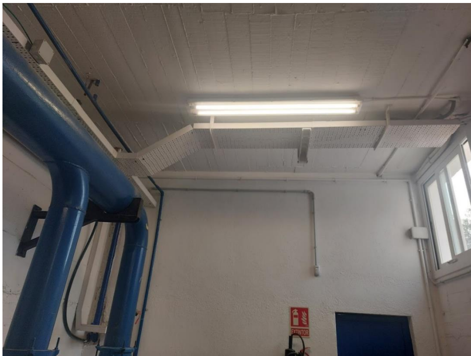
Fotografia 2. Detall del sostre. Els ancoratges han d'evitar interferir amb les safates actuals
