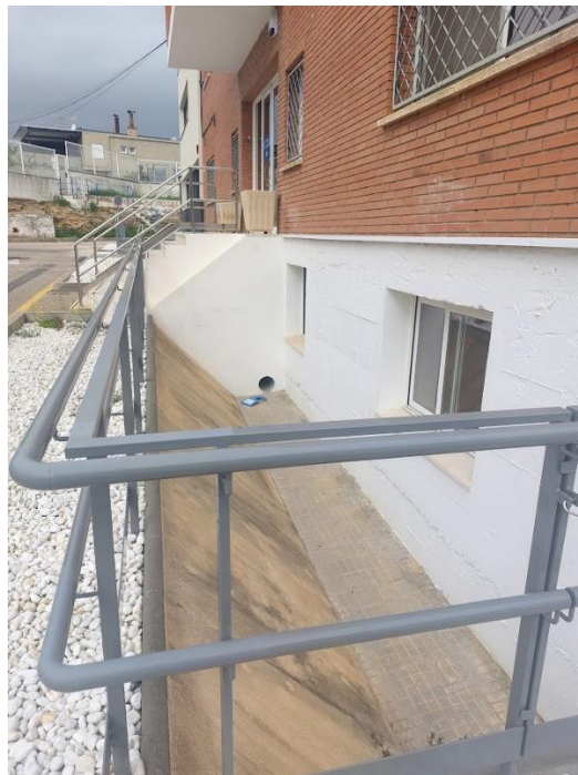
Fotografia 5. Exterior on sortirà el pont grua. (finestra del fons) a modificar per EMATSA
