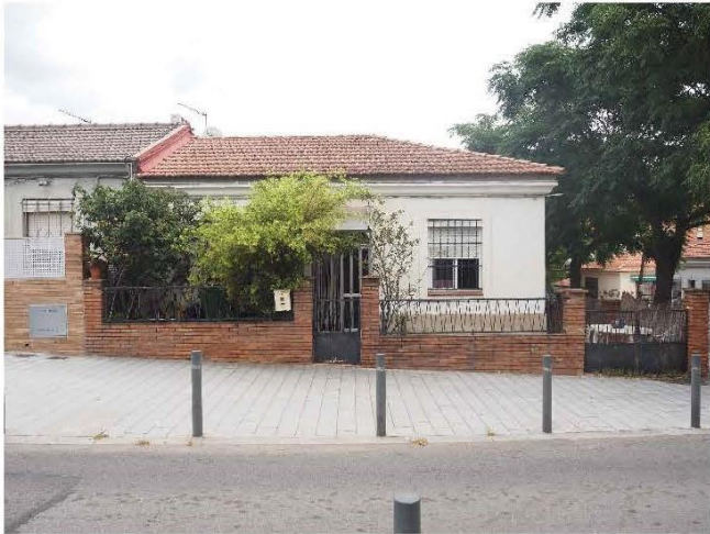
FAÇANA CASETA ESPINAUGA 54
