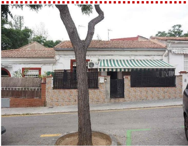
FAÇANA CASETA BELLCAIRE 55
