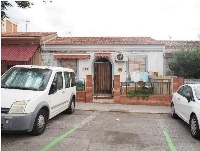
FAÇANA CASETA ESPINAUGA 58
