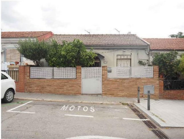
FAÇANA CASETA ESPINAUGA 56
