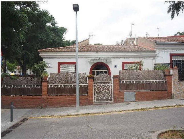
FAÇANA CASETA BELLCAIRE 53
