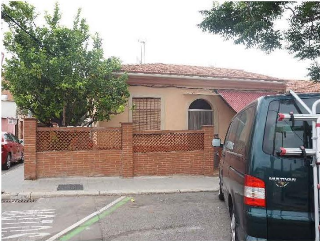
FAÇANA CASETA ESPINAUGA 60
