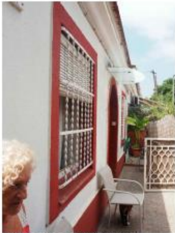
02. TERRASSA EXTERIOR ZONA ACCÉS
