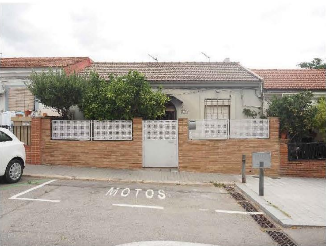
FAÇANA CASETA ESPINAUGA 56
