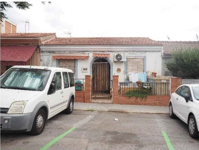
FAÇANA CASETA ESPINAUGA 58
