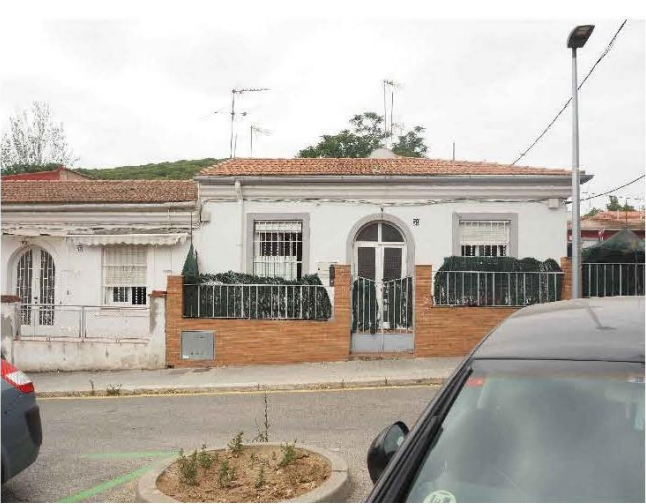
FAÇANA CASETA BELLCAIRE 59
