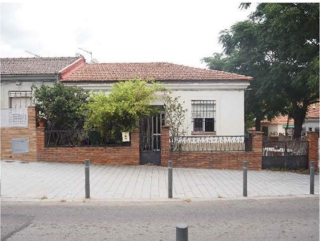
FAÇANA CASETA ESPINAUGA 54
