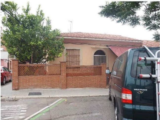
FAÇANA CASETA ESPINAUGA 60
