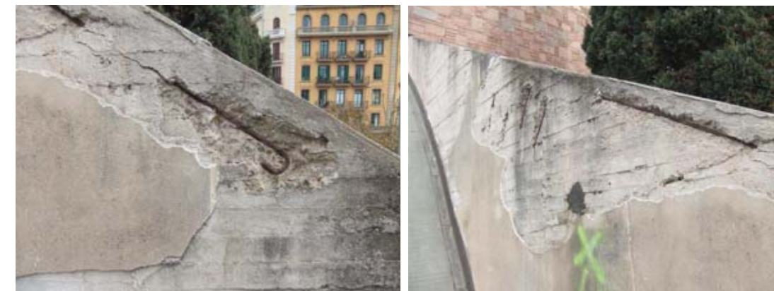
Fotografia 40 – Armadures a l'intempèrie en els contraforts de l'arc
