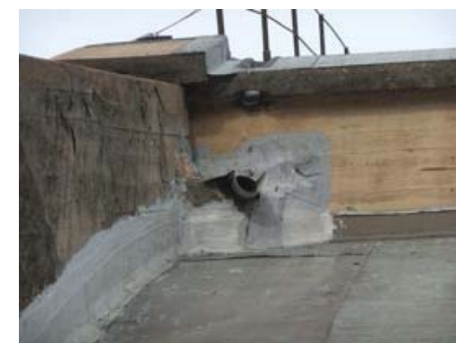
Fotografia 20 - Cara oposada de l'embornal del primer nivell de desguàs en l'arc 6
