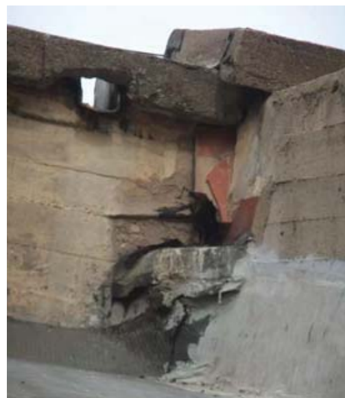
Fotografia 24 - Cara oposada de l'embornal del primer nivell de desguàs en l'arc 5
