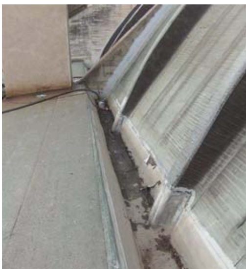
Fotografia 28- vista parcial arcs 1 i 2
