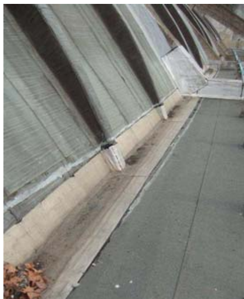
Fotografia 25-canal de recollida des de arc 4
