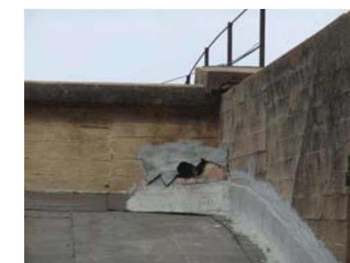
Fotografia 21 - Cara oposada de l'embornal del primer nivell de desguàs en l'arc 6
