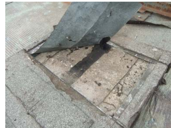
Fotografia 39 – Bon estat del formigó de l'arc sota el mimbell metàl·lic
