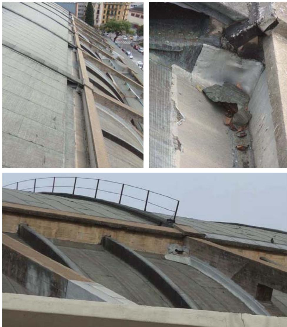
Fotografia 13 – Cara oposada del embornal des de coberta lateral Zona 2
