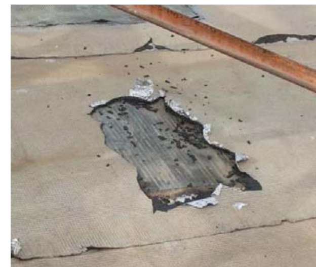
Fotografia 34 – Forat a la làmina d'impermeabilització
