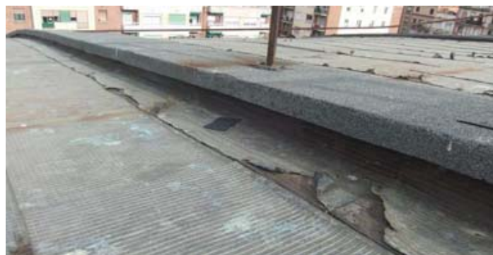
Fotografia 38 – Mimbell superior de l'arc de formigó
