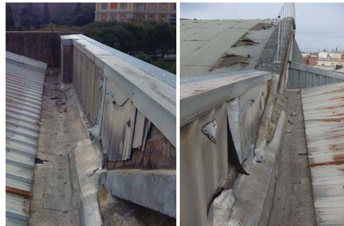
Fotografia 3 – Canaló costat arc
