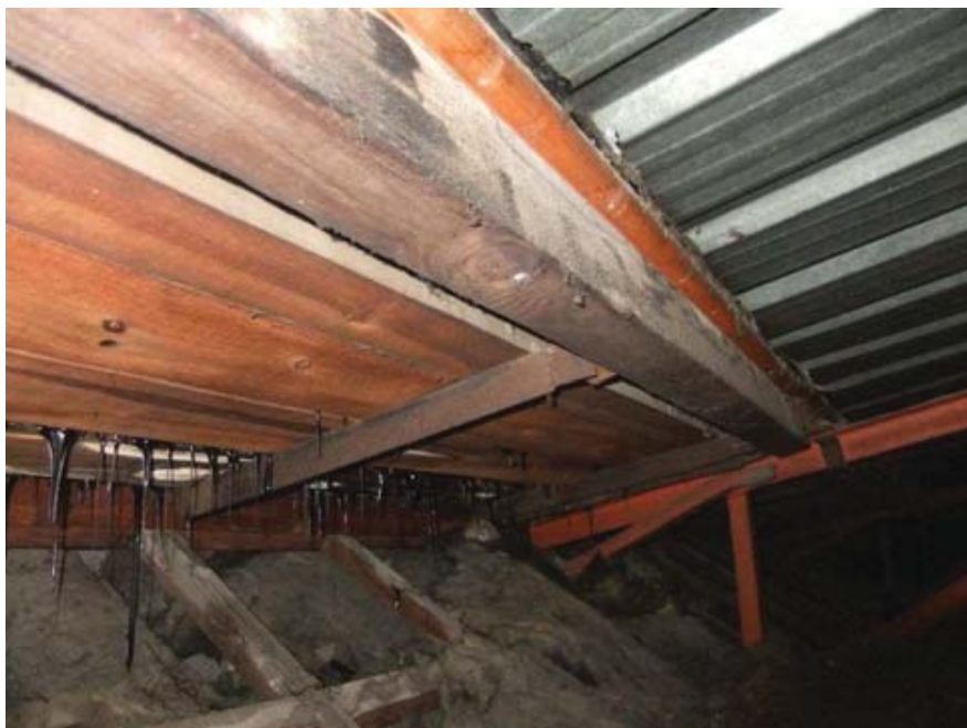
Fotografia 5 – Cara interna del canaló de fusta
