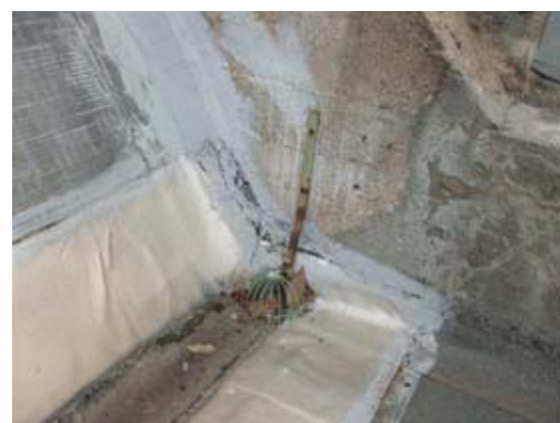
Fotografia 16 - Embornal embussat arc 8
