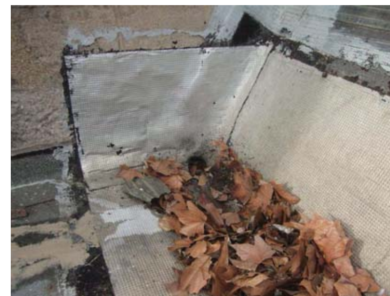
Fotografia 22 - Embornal de l'arc 5 tapat per fulles
