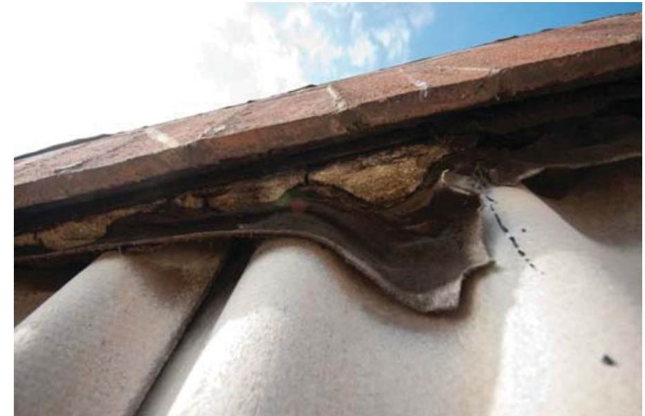
Fotografia 10 – Vista parcial de la part superior de la xapa ondulada i del faldó protector.
