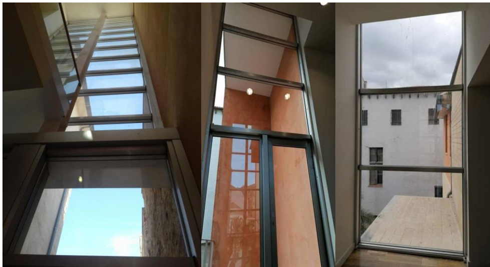
Fig. 2. Murs cortina i finestres grans edifici c/ Montcada 23 (Palau Abària) Caldrà que es tingui en compte que també formen part dels espais a netejar de l'edifici de la Plaça Gerard Vergés, les escales d'evacuació (d'emergència) situades a les façanes de l'edifici que donen als carrers Cabanes i Montcada
