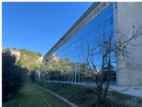
Façana posterior – mur cortina.
