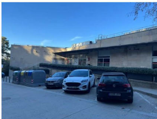
Façana principal - accés planta baixa.
