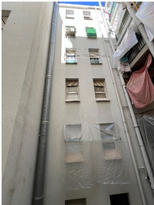
*Façana interior est de l'edifici 6C.
