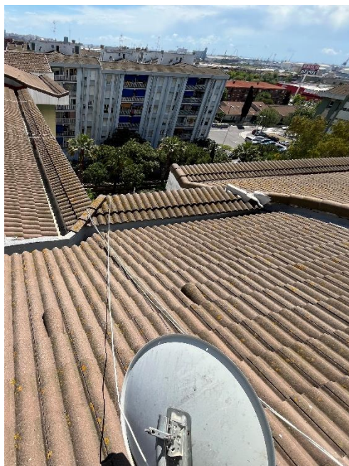
*Coberta inclinada 3 de l'edifici 6C.
