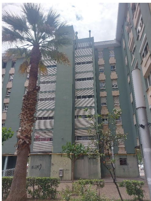
*Façana nord de l'edifici 6G.
