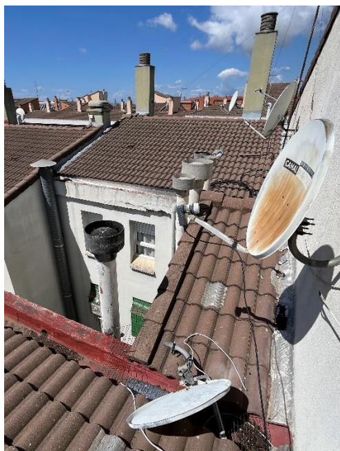
*Cobertes inclinades 1 i 4 de l'edifici 6C.
