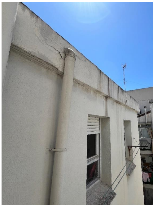
*Façana interior oest de l'edifici 6C.
