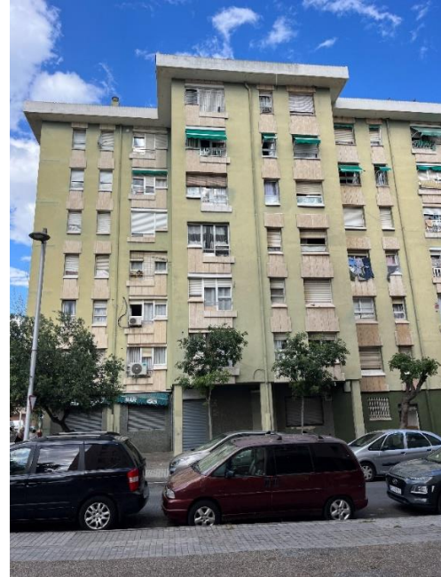
*Façana oest de l'edifici 6C.
