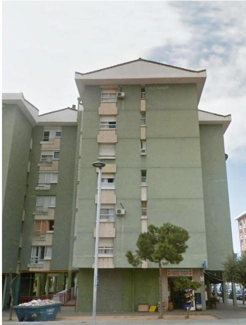
*Façana nord de l'edifici 6C.
