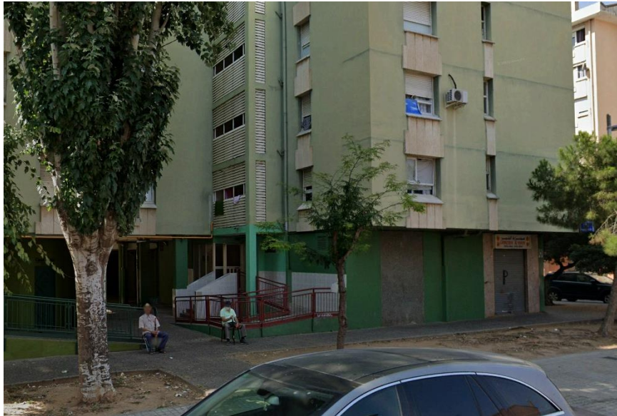
*Accés a l'edifici 6C.
