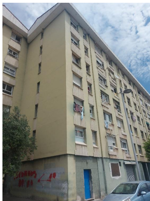
*Façanes sud i oest de l'edifici 6G.
