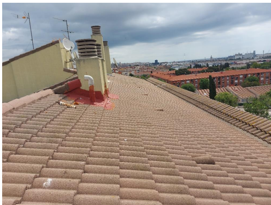
*Cobertes inclinades 1 i 2 de l'edifici 6G.
